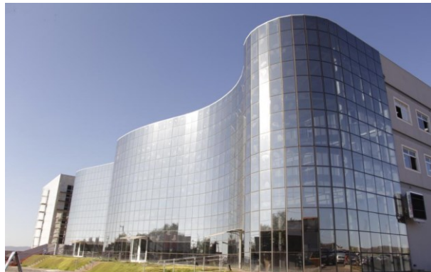
Figura 12 – Vista frontal do Centro Administrativo da Prefeitura de Paracatu-MG.
