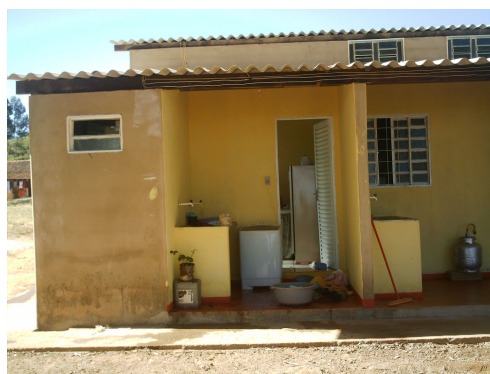
Figura 16: Vista de uma das Residências
