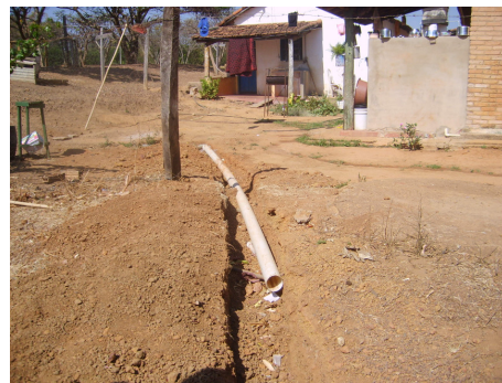
Figura 14: Construção das fossa sépticas
