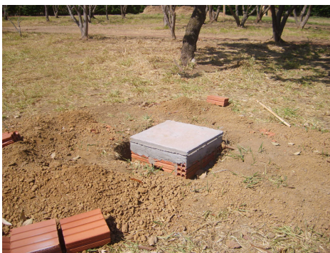
Figura 13: Construção da fossa séptica
