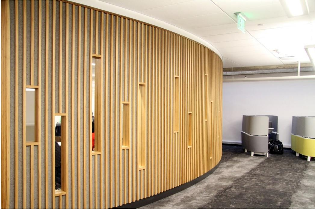
Fig. 26 – Divisória em bambu
