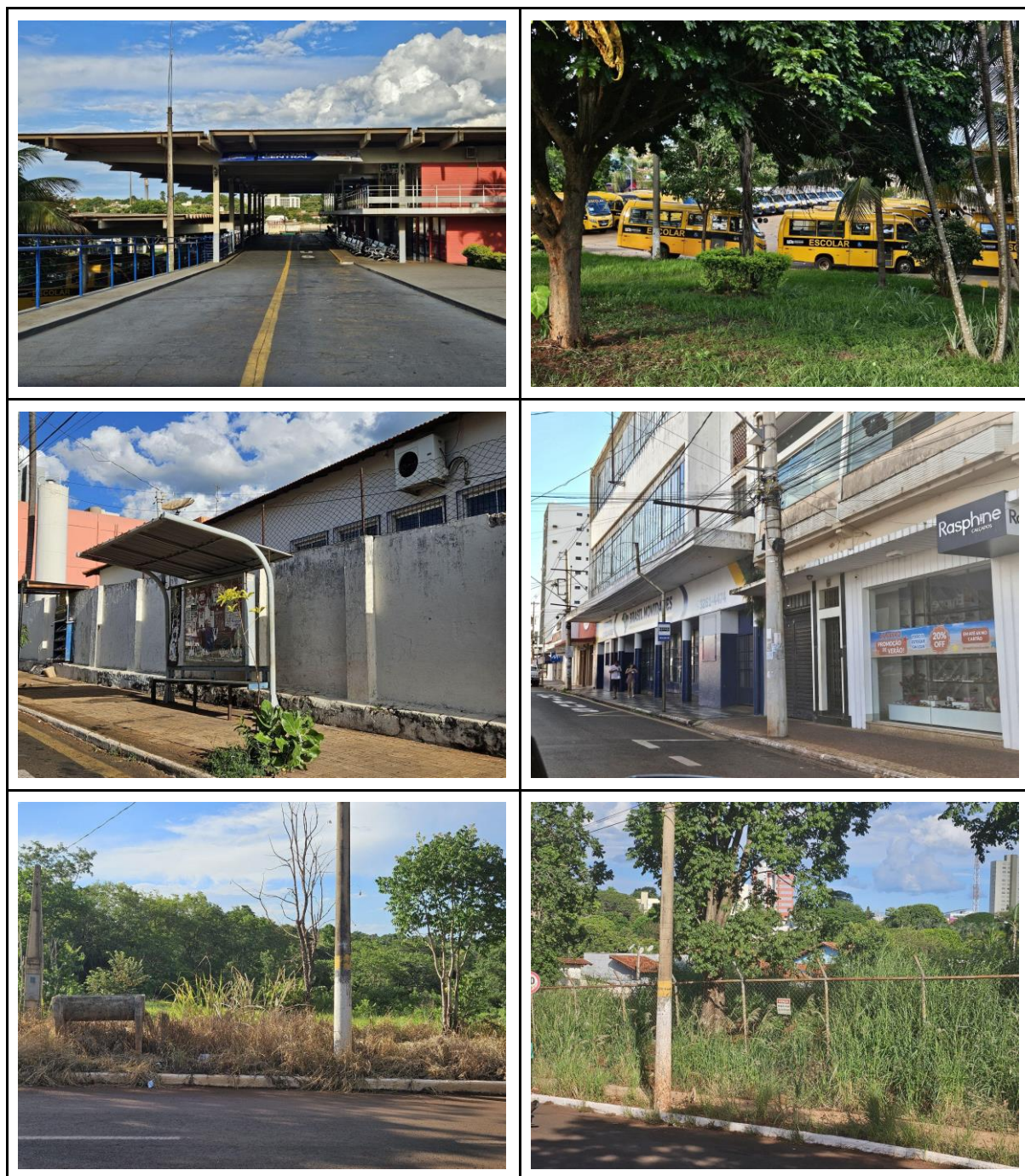
Figura 37 - Ituiutaba: Estrutura do “Busão do Povo” (2024)
