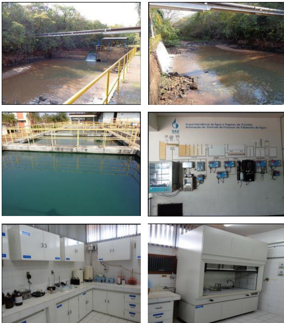
Figura 30 - Ituiutaba: Infraestrutura da SAE (2014)
