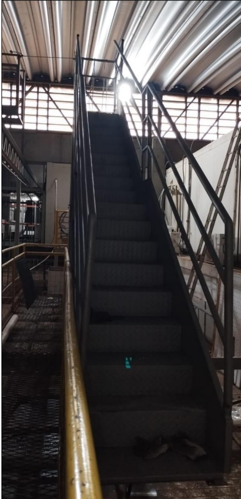
Figura 48: Escada da construída, ainda a pintar (Foto retirada pela equipe de manutenção da empresa “A” a pedido do autor, 2023).
