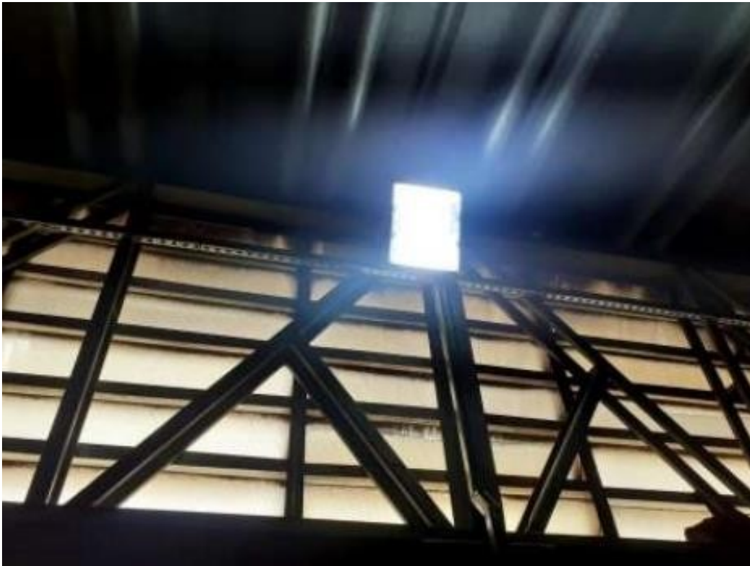
Figura 11: Iluminação de um ponto com refletor e a infraestrutura em perfilado abaixo readequada (Acervo de documentos da empresa “A”, 2023).
