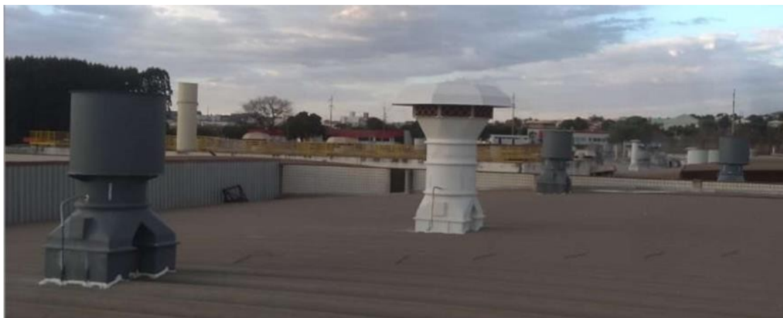
Figura 31: Telhado da fábrica com os exaustores já instalados (Acervo de documentos da empresa “A”, 2023).
