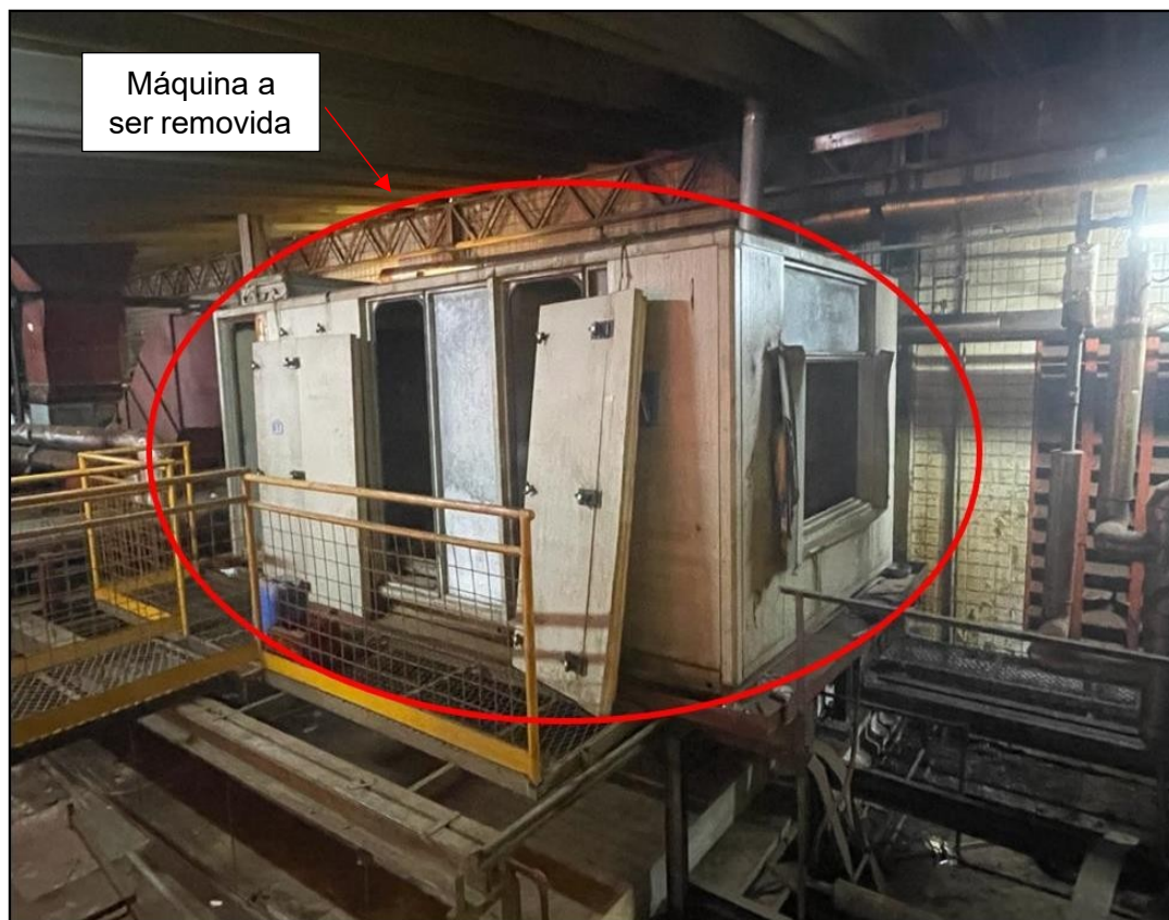
Figura 18: Máquina 1 de climatização desativada a ser removida (antes) (Acervo de documentos da empresa "A", 2023).
