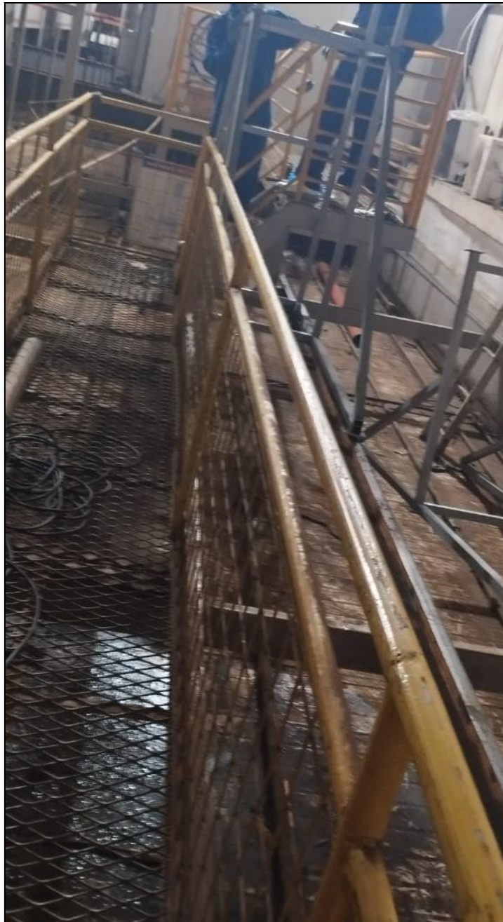
Figura 47: Registro de construção de uma nova escada dentro dos padrões das normas brasileiras (Foto retirada pela equipe de manutenção da empresa “A” a pedido do autor, 2023).
