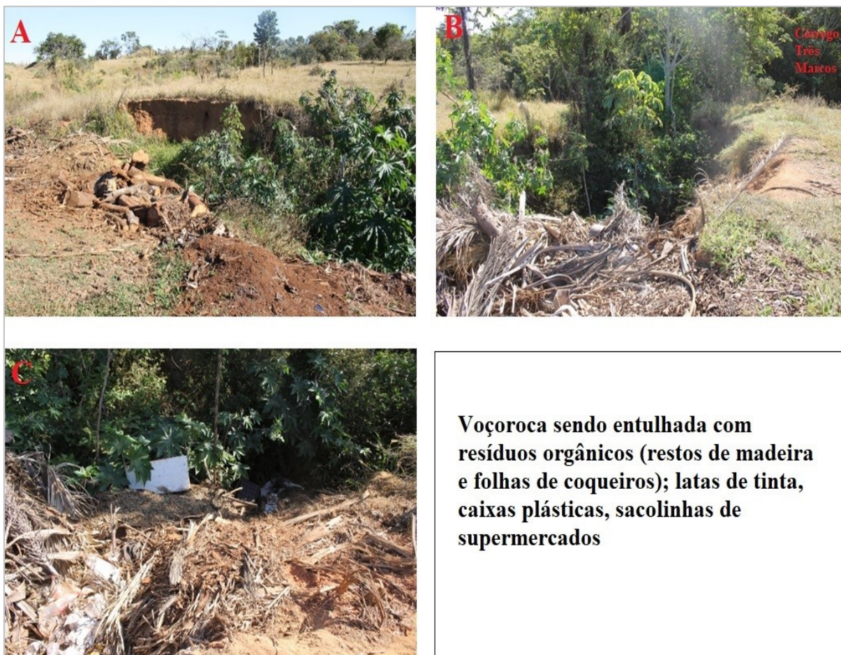
Figura 47 – Voçoroca sendo aterrada com diversos resíduos sólidos, na margem direita do córrego Três Marcos, ao final de seu alto curso – BHCVT.
