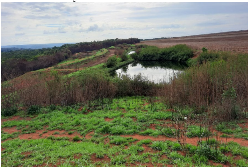
Foto 45 – Vista parcial das bacias de retenção/detenção da drenagem pluvial oriunda do bairro Morumbi inseridas na margem direita da nascente do córrego Três Marcos – BHCbVT.
