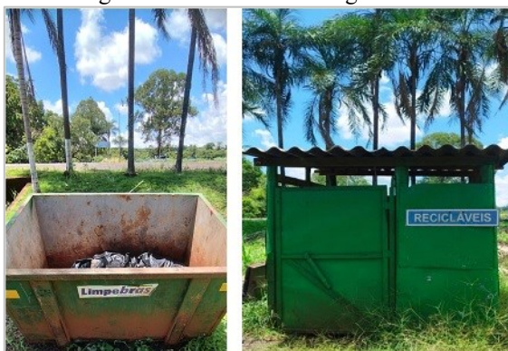
Figura 26 – À esquerda: Caçamba para armazenamento temporário de resíduos sólidos. À direita: Casinha para armazenamento de resíduos para reciclagem na venda Olhos D'Água – Comunidade Olhos D'Água – BHCbVT.
