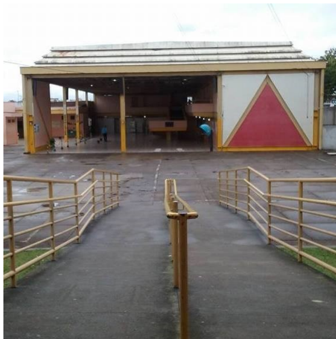
Figura 4: Fachada da Escola Estadual Nazle Jabur.
