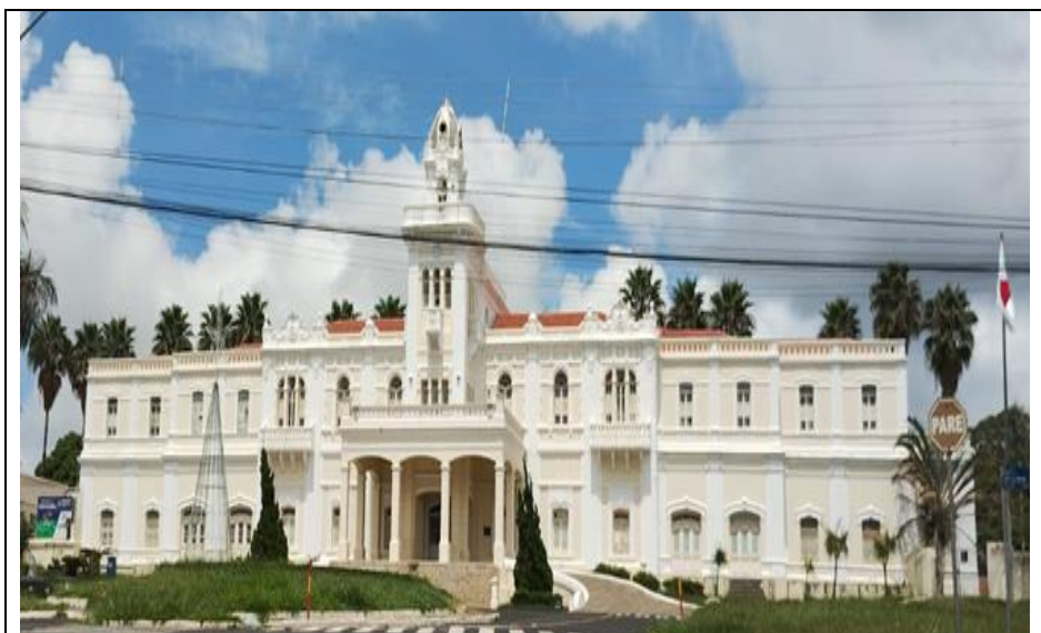
Figura 55- Foto da Sede da Prefeitura de Araguari, restaurada, antiga Companhia da Estrada de Ferro de Goyaz. Foto da autora em 06 de janeiro de 2024.
