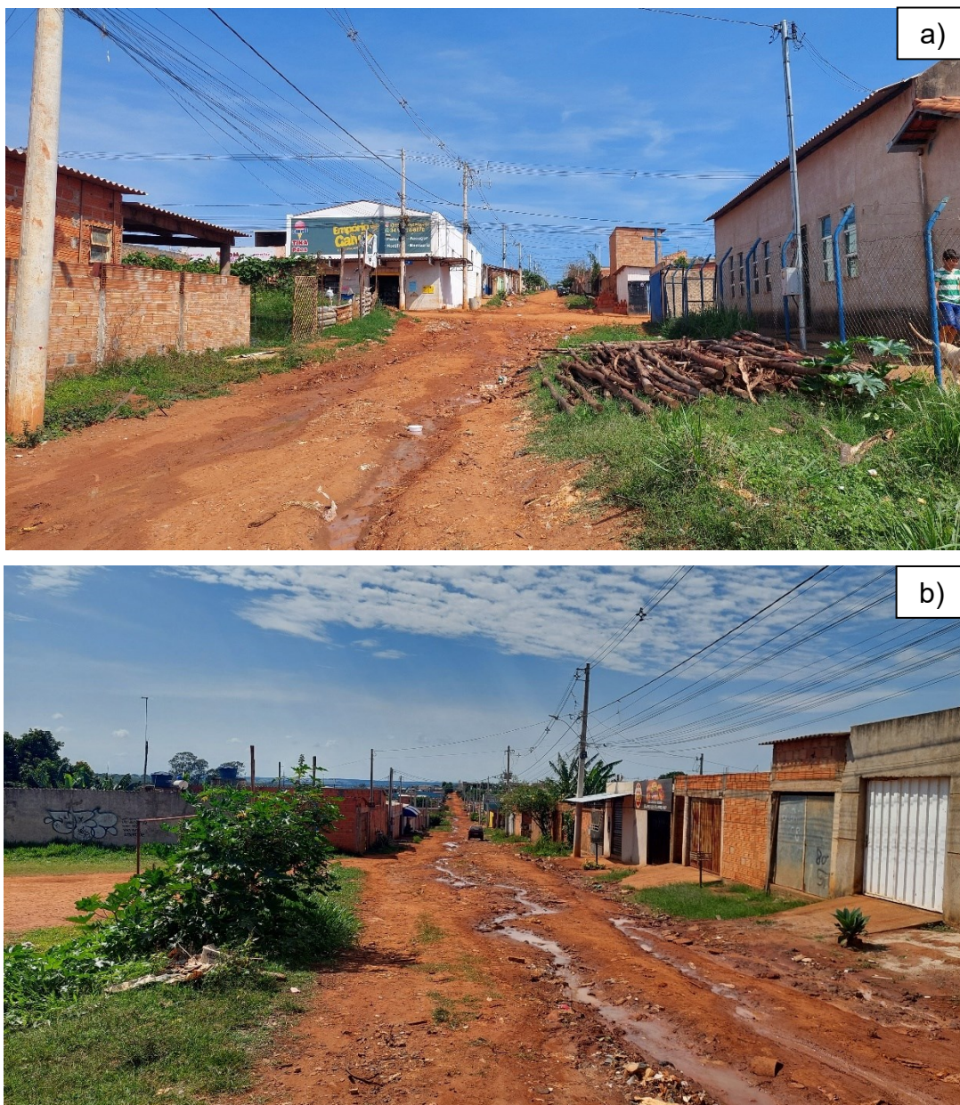
Figura 42. Uberlândia – MG: Condições de precariedade no bairro Élisson Prieto (2023)
