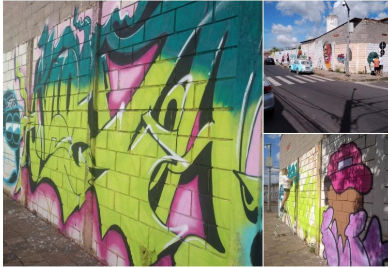
Figura 43 - Vista da esquina da escola.
