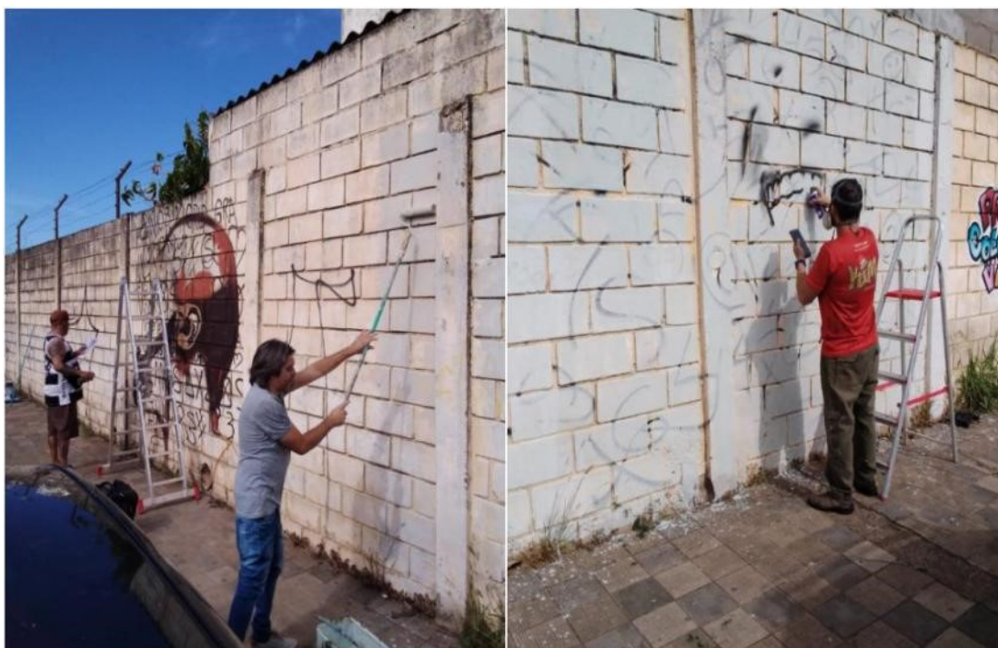
Figura 36 - Pintura do muro com tinta látex branco, preparação para aplicação dos grafites.
