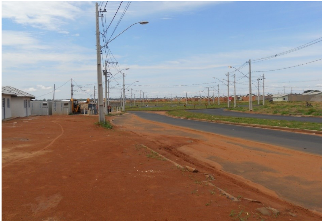
Fotografia 5 – Casas construídas, ainda sem passeios, no Residencial Pequis. Uberlândia-MG, 2017.
