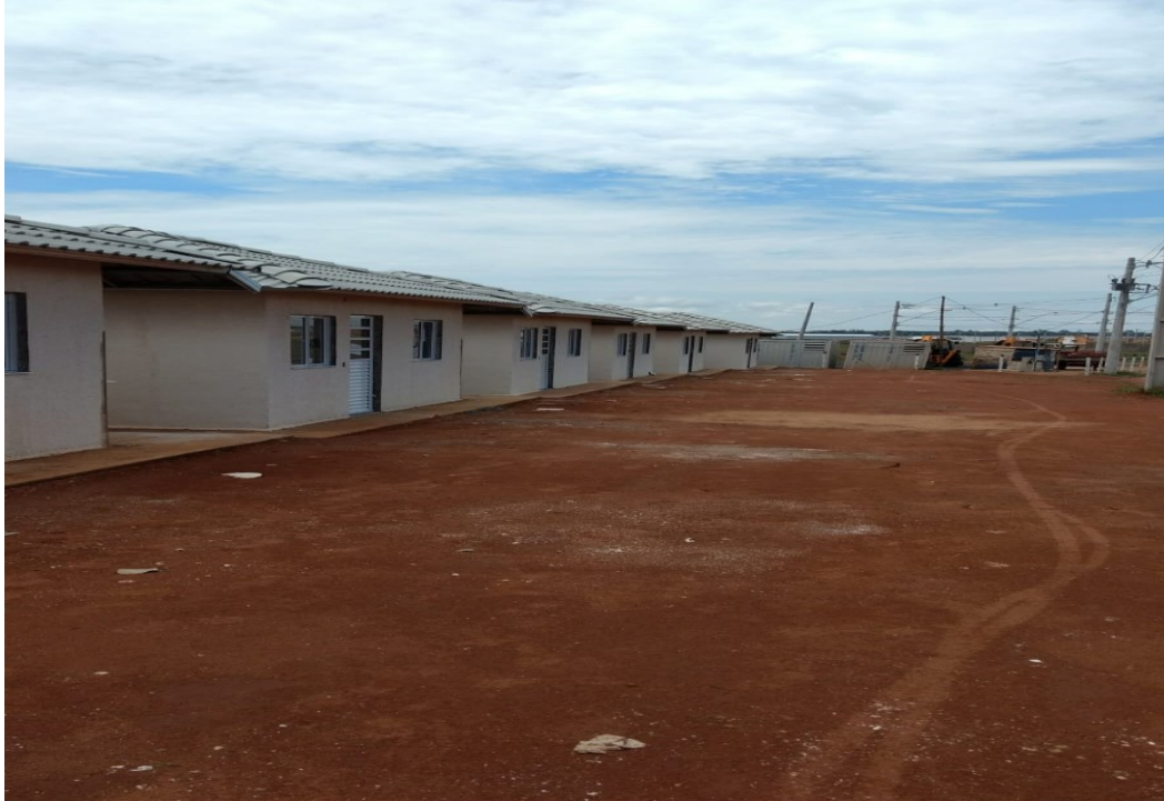
Fotografia 4 – Casas construídas, ainda sem passeios, no Residencial Pequis. Uberlândia-MG, 2017.
