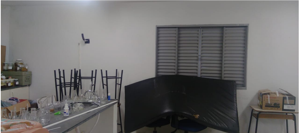
Figura 5: Registro fotográfico da janela para ventilação do laboratório.
