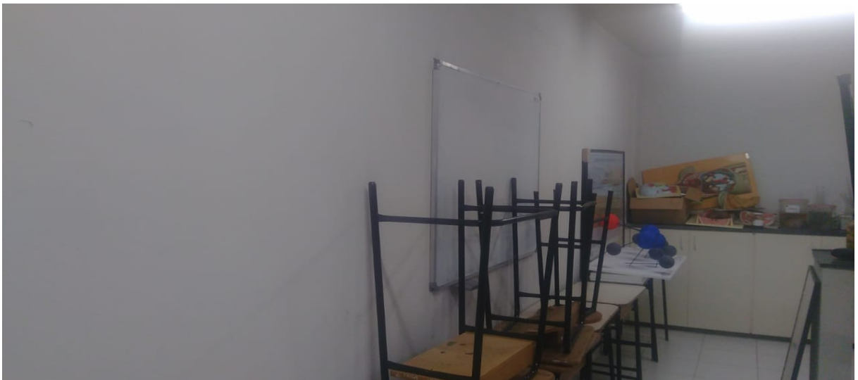
Figura 2: Registro fotográfico das paredes de alvenaria.
