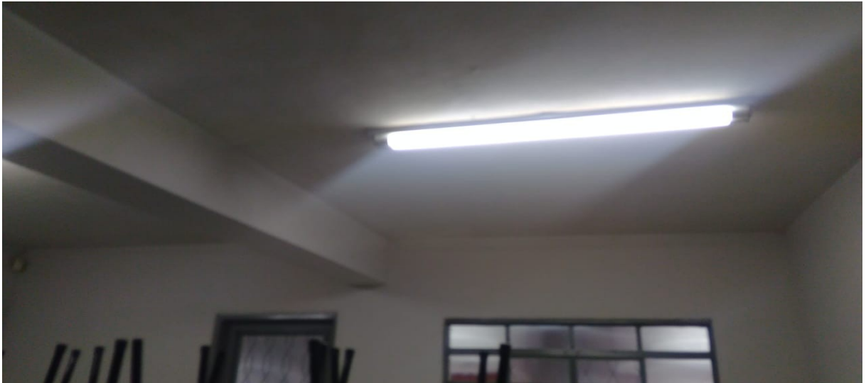
Figura 3: Registro fotográfico do teto do laboratório.
