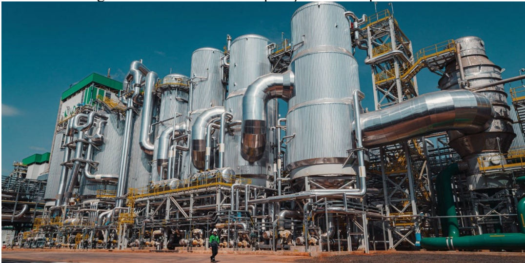
Figura 201 – Sistema de Evaporação de múltiplos efeitos.
