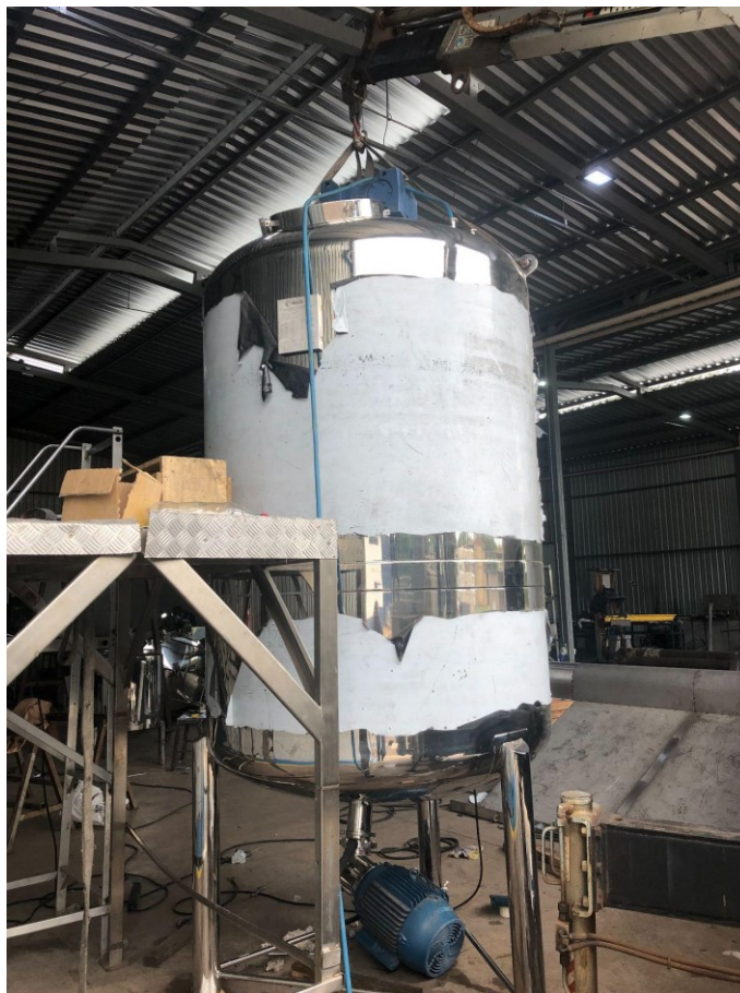
Figura 35 - Foto em campo, montagem e teste hidrostático, Tanque IRS-TT-3000 INOX 316
