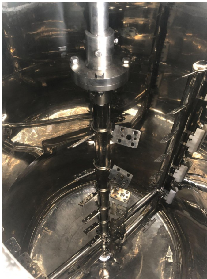
Figura 36 - Foto em campo, Sistema de agitação tipo Âncora do tanque IRS-TT-3000 INOX 316, após teste hidrostático
