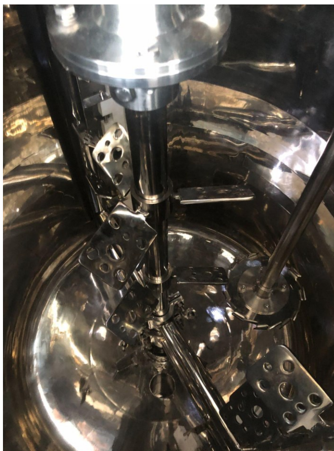
Figura 42 - Foto em campo, Sistema de agitação tipo Âncora e disco de Cowles do tanque IRL-TT-500 INOX 316, após teste hidrostático
