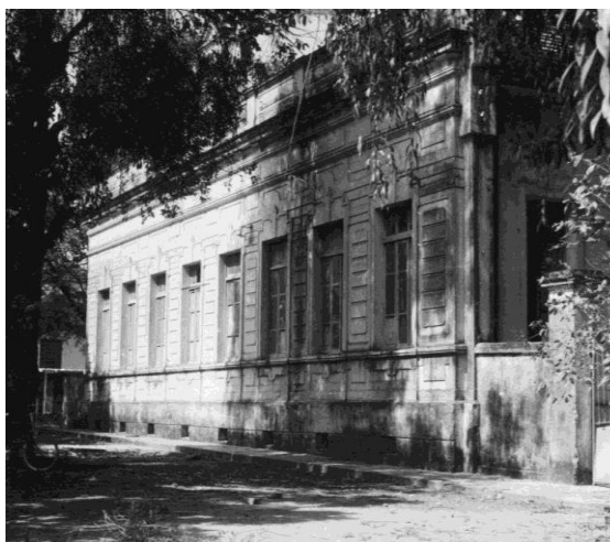
Figura 6 - Colégio Júlio Bueno Brandão - Demolido em 1963
