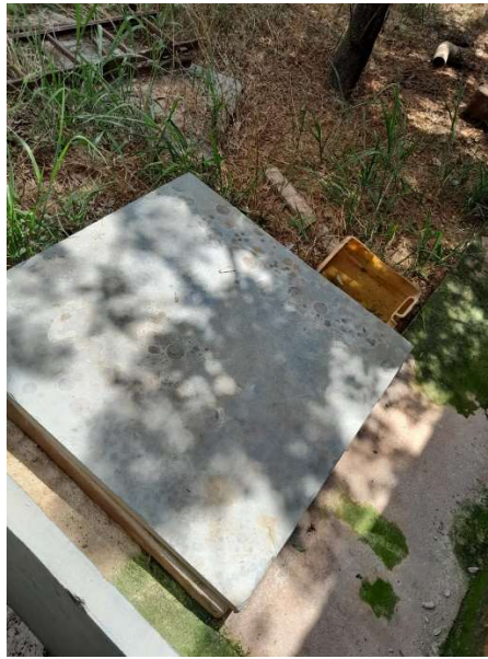
Figura 19 – Caixa de passagem central.
