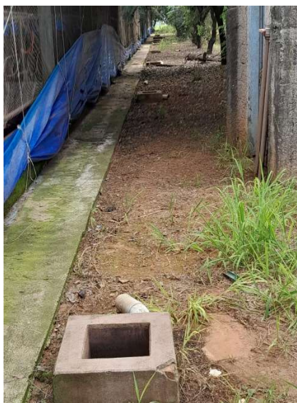
Figura 18 – Caixas de passagem menores.
