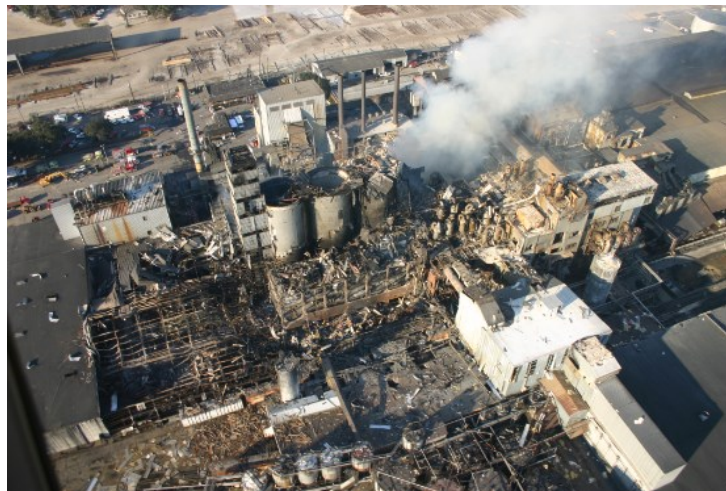
Figura 5: Explosão e incêndio Imperial Sugar Company.
