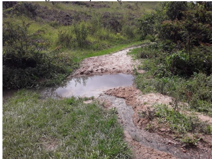
Figura 12. Poço de esgoto a céu aberto.
