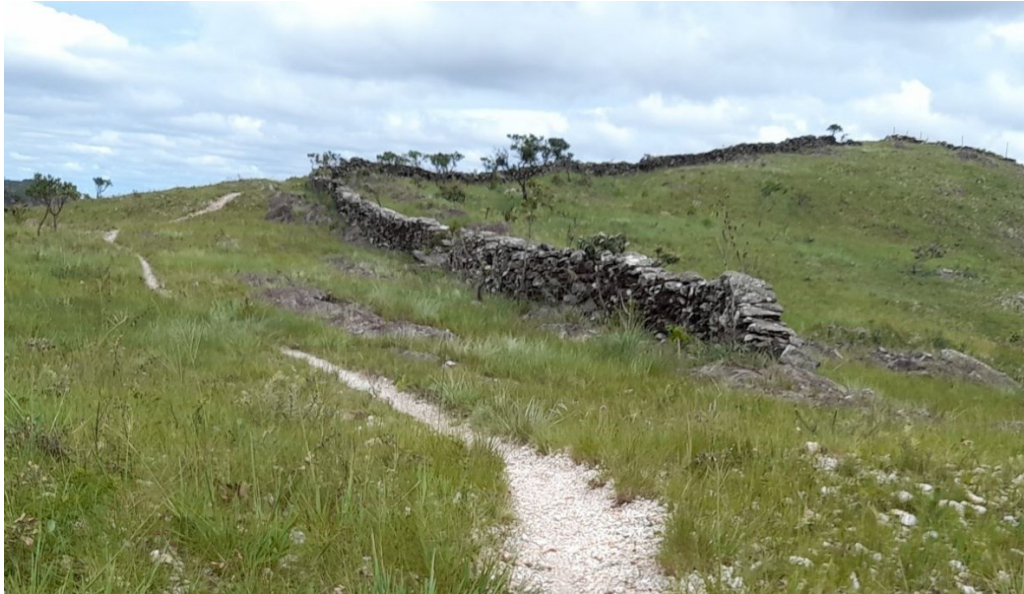
Figura 8. Muro de Pedra. Um pequeno trecho do muro que fica localizado próximo ao bairro Senhor dos Montes, em toda a paisagem da Serra existe resquícios do muro de pedra.
