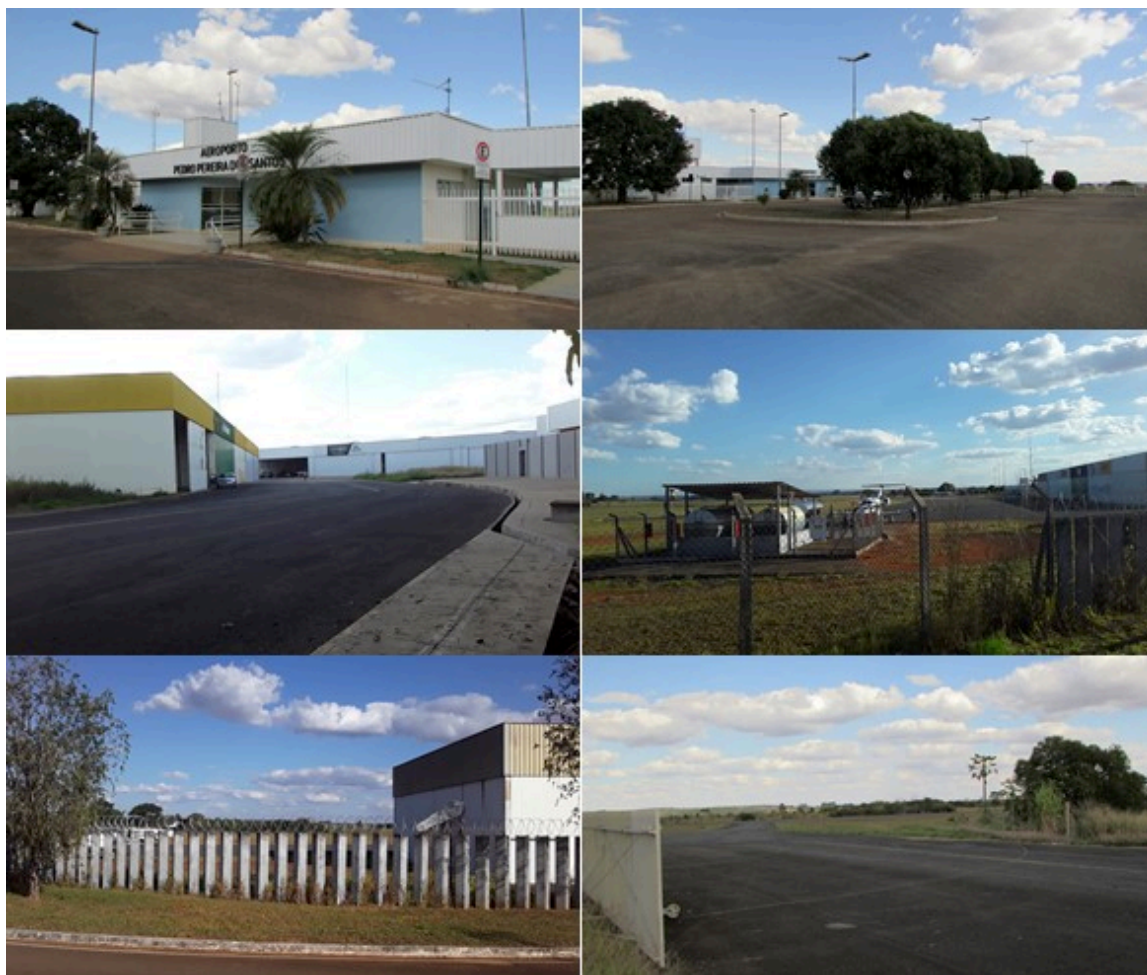
Figura 63. Infraestrutura do aeroporto de Patos de Minas (MG). 2023.
