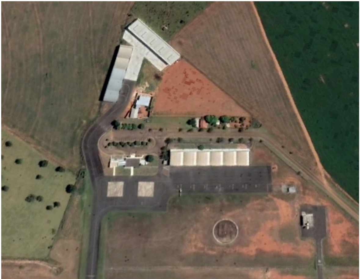
Figura 62. Pista de táxi e pátio de aeronaves. Aeroporto de Patos de Minas (MG). 2024.
