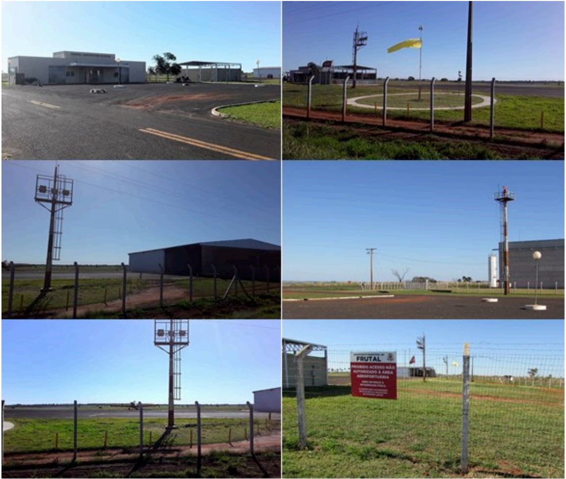
Figura 72. Infraestrutura do aeroporto de Frutal (MG). 2023.
