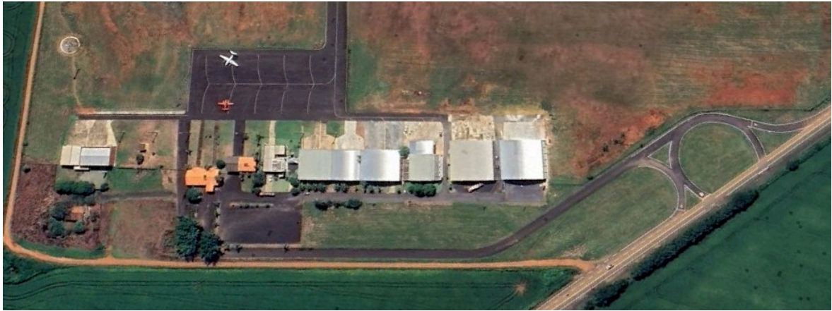
Figura 56. Pista de táxi e pátio de aeronaves. Aeroporto de Catalão (GO). 2023
