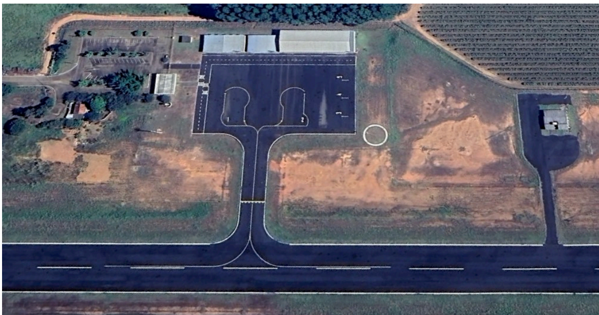
Figura 59. Pista de táxi e pátio de aeronaves. Aeroporto de Patrocínio (MG). 2024.
