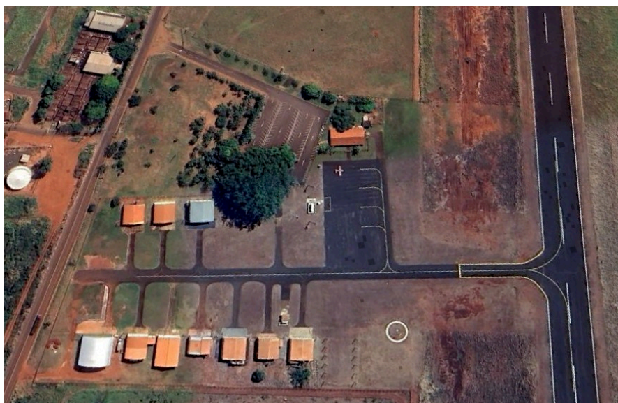
Figura 45. Pista de táxi, pátio de aeronaves, terminal de passageiros e hangares. Aeroporto de Ituiutaba (MG). 2024.
