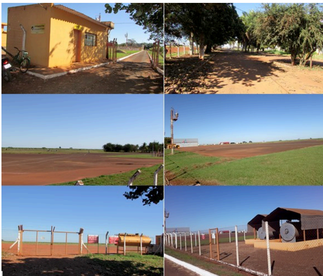
Figura 75. Infraestrutura do aeroporto de Iturama (M). 2023.
