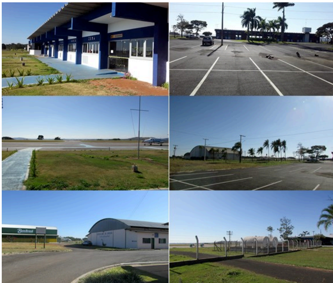
Figura 66. Infraestrutura do aeroporto de Araxá (MG). 2023.
