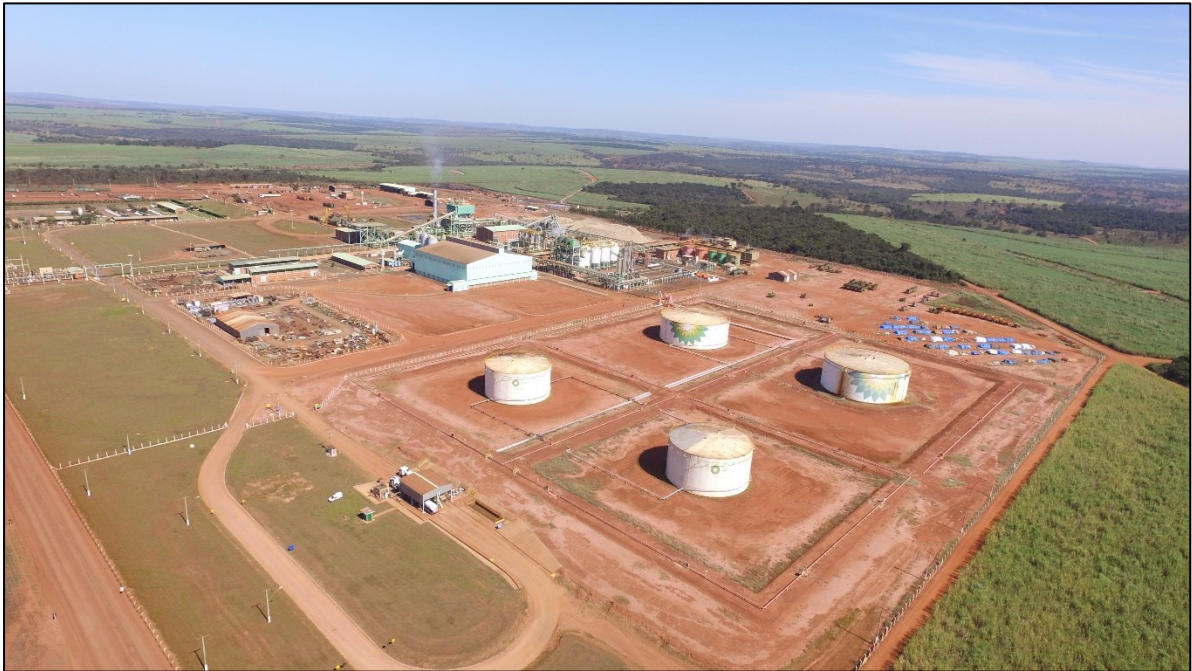
Figura 10 – Tanques de armazenamento de etanol da unidade BP Bunge Ituiutaba
