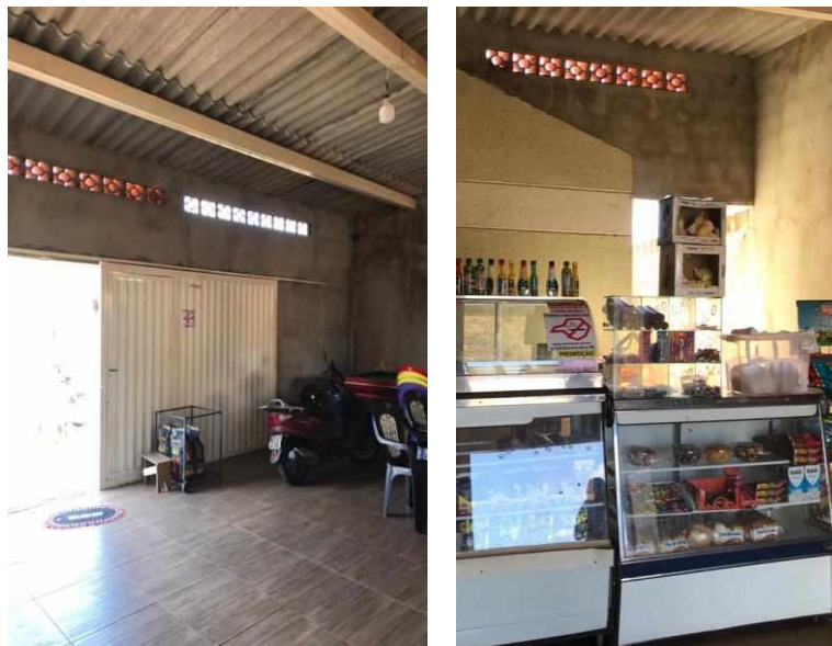
Figura 73 - UH com tijolo vazado no Residencial PQ
