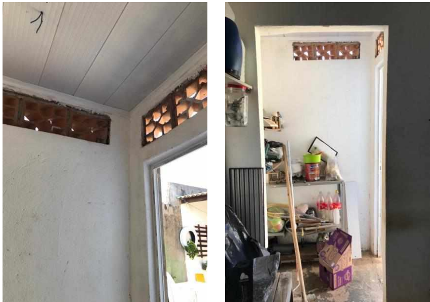
Figura 74 - UH com tijolo vazado no Residencial SB
