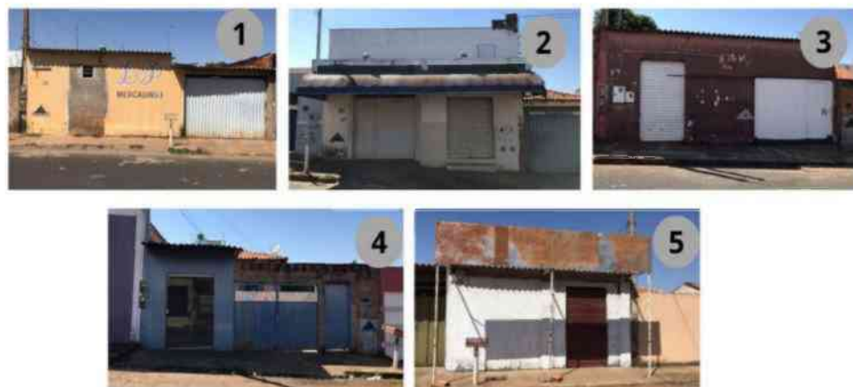
Figura 44 - Mosaico de fachadas desativadas no Residencial SB
