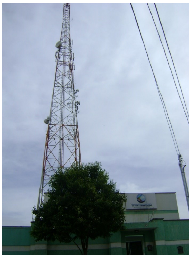
Figura 10: Estação de retransmissão de TV digital
