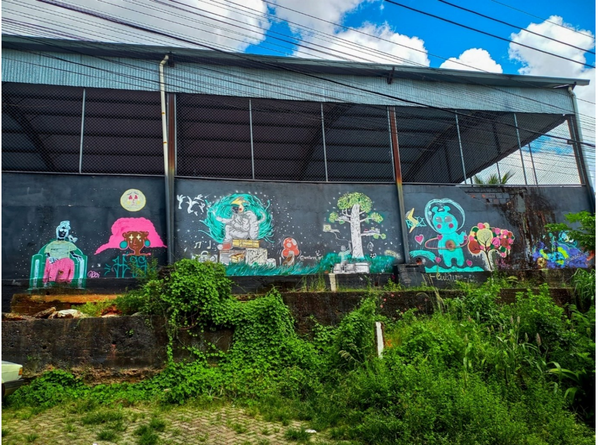
Parede externa da quadra da Escola Martin Luther King, localizada na Rua Ipiranga. Fonte: Arquivo Pessoal (2023).
