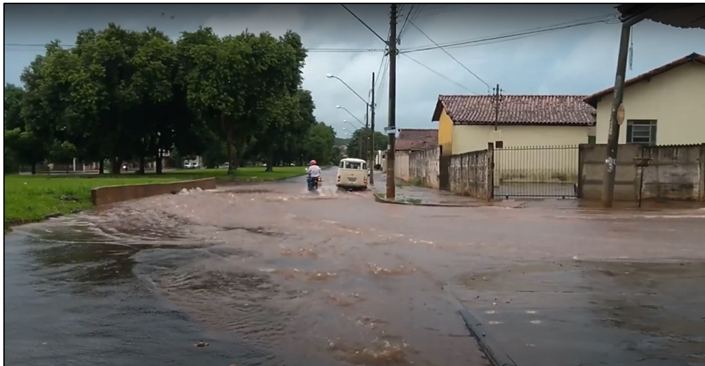
Figura 8. Alagamento em área de vertente impermeabilizada do Córrego São José – Ituiutaba/MG
