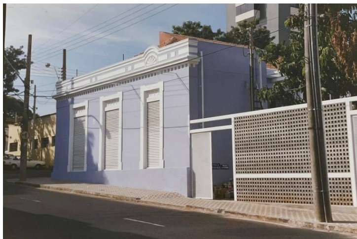
Figura 14. Fotografia da fachada lateral do MUnA – Rua XV de Novembro.
