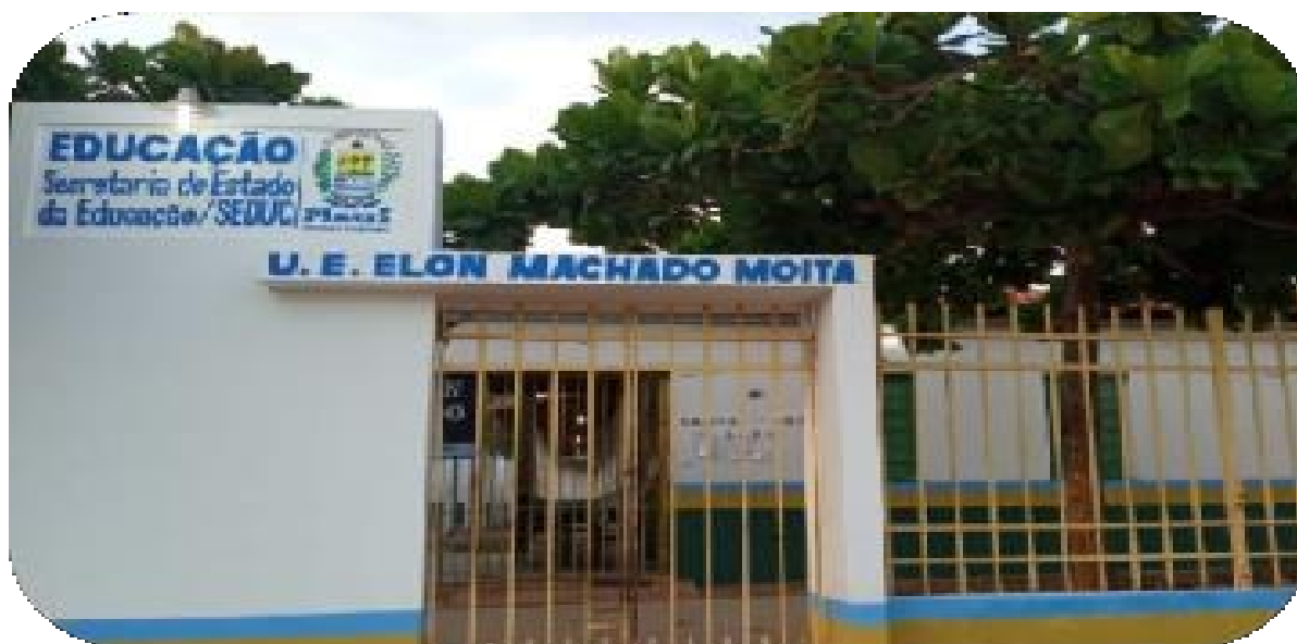
Foto 8. Fachada do prédio da Escola Elon Machado Moita - Fonte: arquivo: Elon
