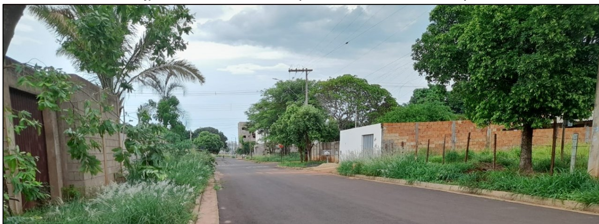
Figura 4: Ausência de calçadas em rua do bairro Tupã
