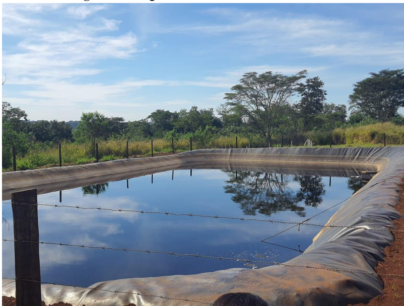
Figura 12: Lagoa de chorume no aterro sanitário.
