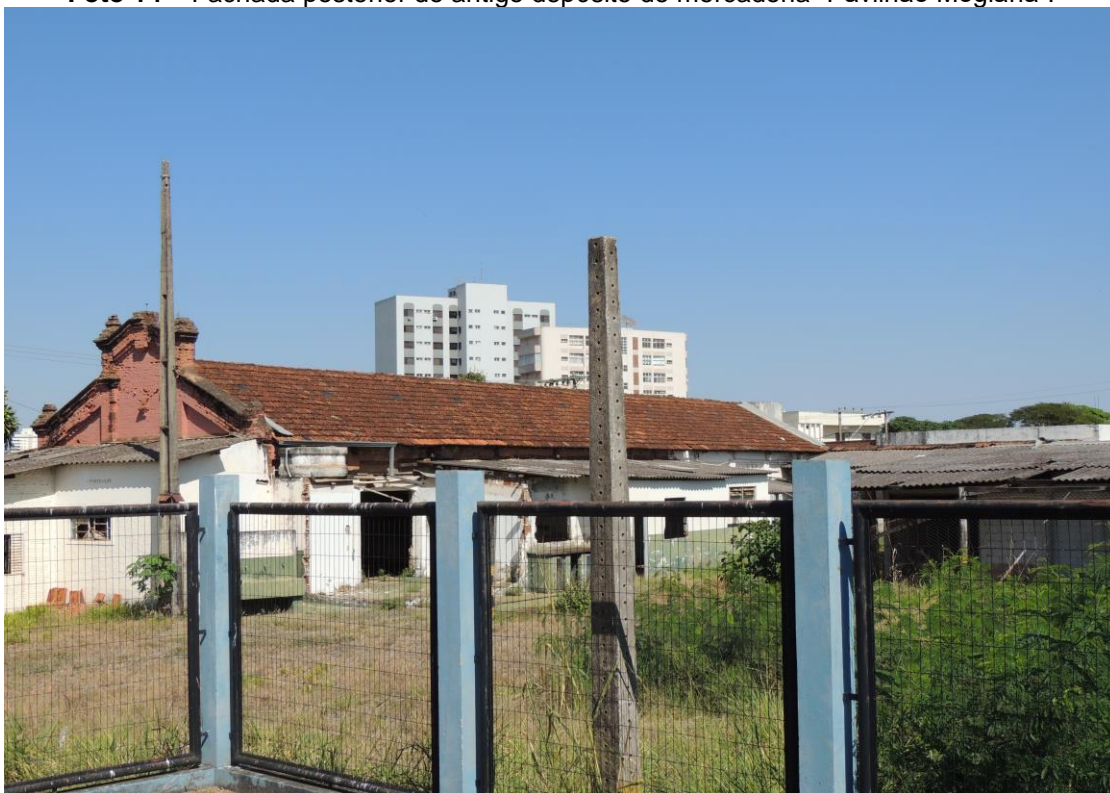
Foto 14 – Fachada posterior do antigo depósito de mercadoria “Pavilhão Mogiana”.
