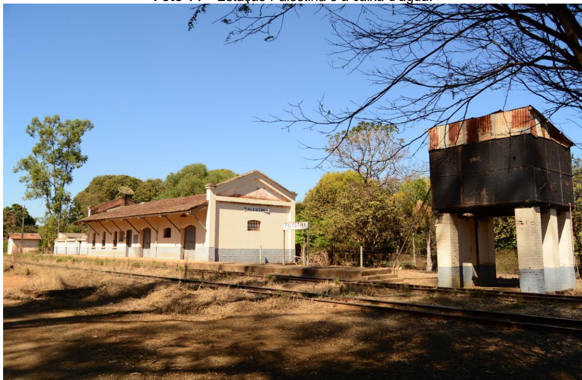
Foto 14 – Estação Palestina e a caixa d'água.
