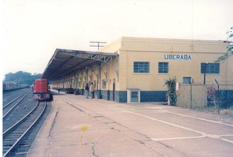
Foto 1 – Segunda estação da CMEF em Uberaba, quando era um depósito.
