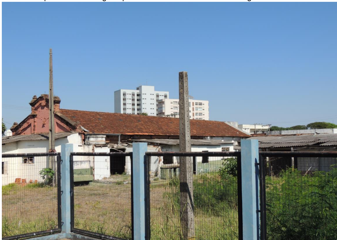
Foto 14 – Vista posterior do antigo depósito de mercadoria “Pavilhão Mogiana” da CMEF em Uberaba.
