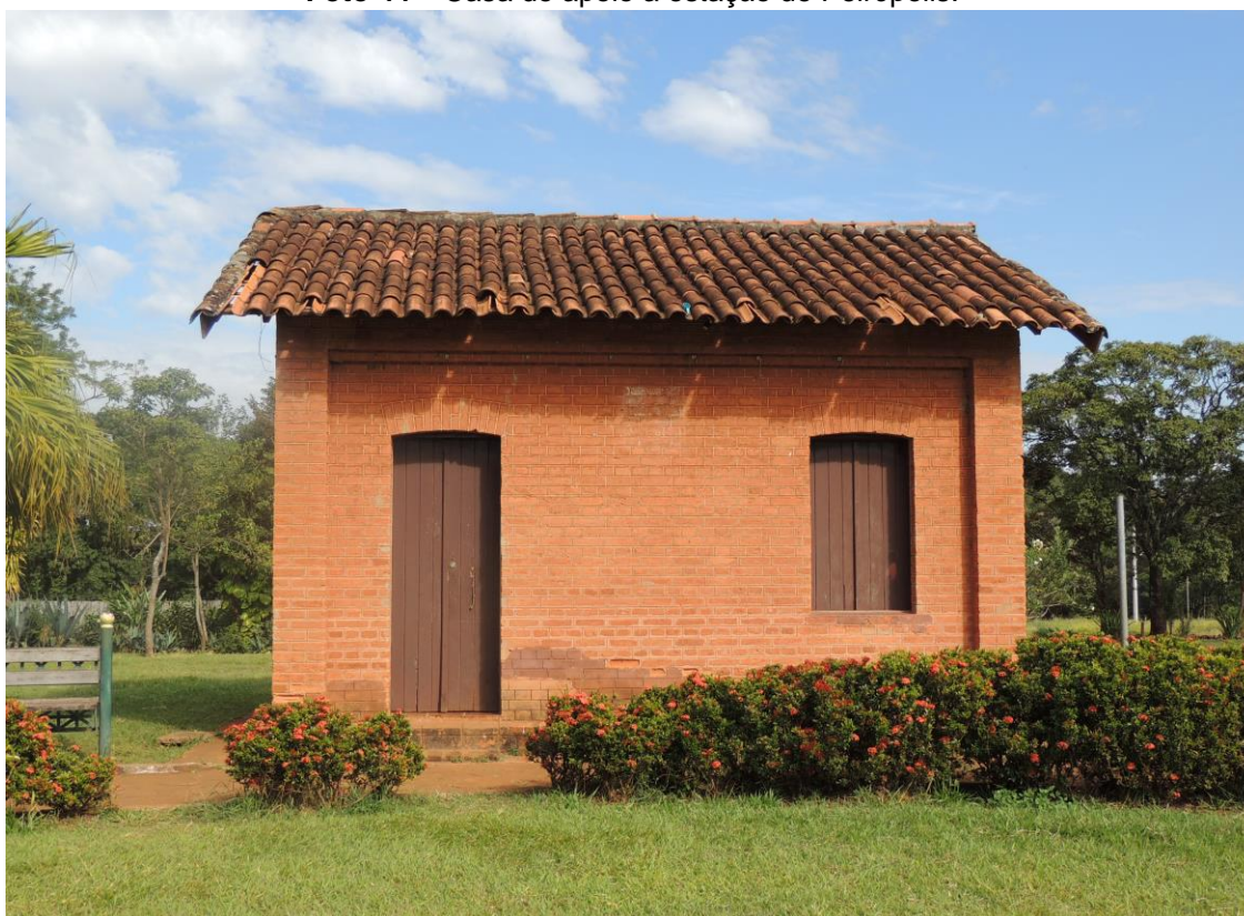
Foto 44 – Casa de apoio a estação de Peirópolis.
