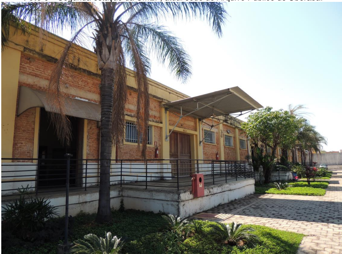
Foto 6 – Segunda estação da CMEF, atual sede do Arquivo Público de Uberaba.
