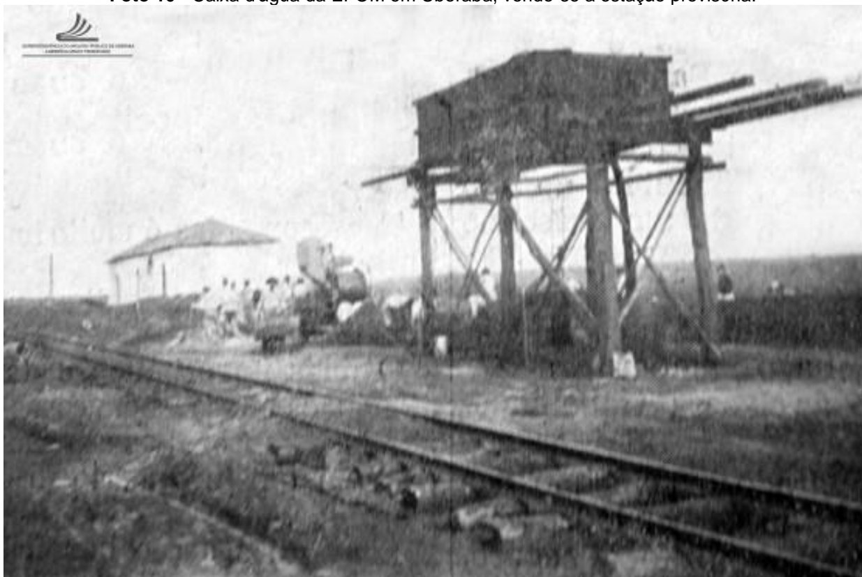
Foto 10 - Caixa d'água da EFOM em Uberaba, vendo-se a estação provisória.
