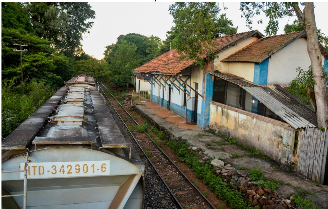
Foto 71 – Estação Bатуíra e entorno.
