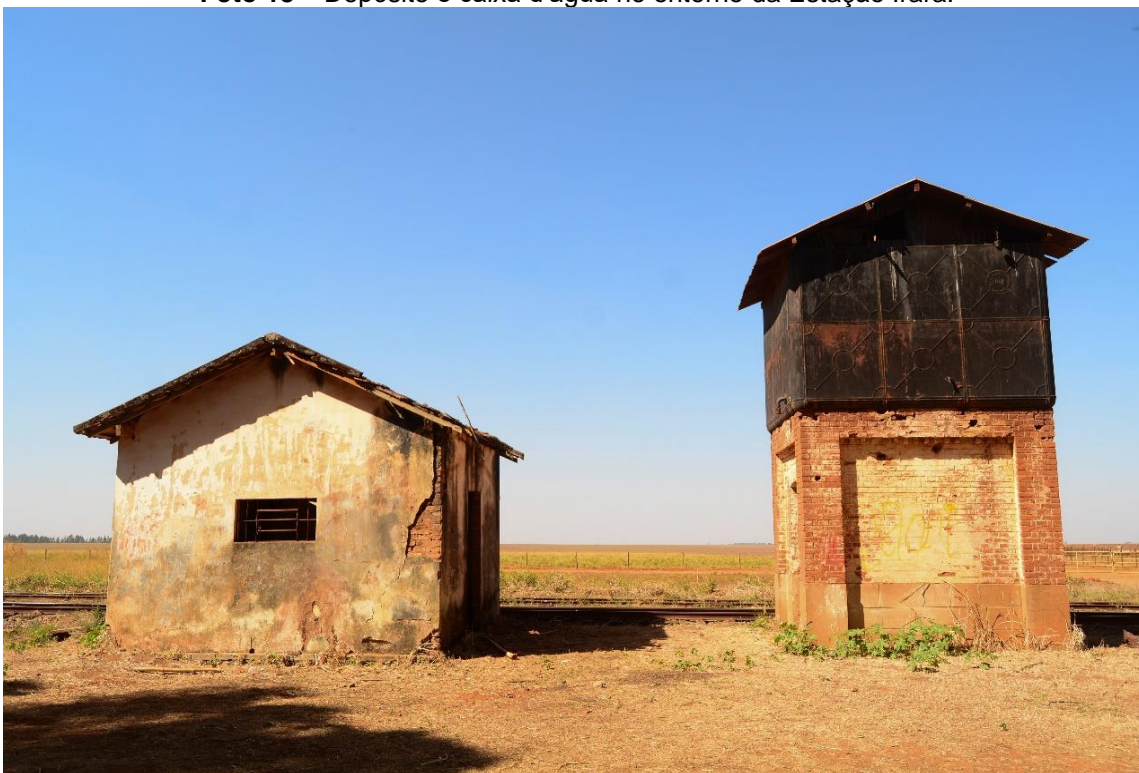
Foto 18 – Depósito e caixa d'água no entorno da Estação Irara.
