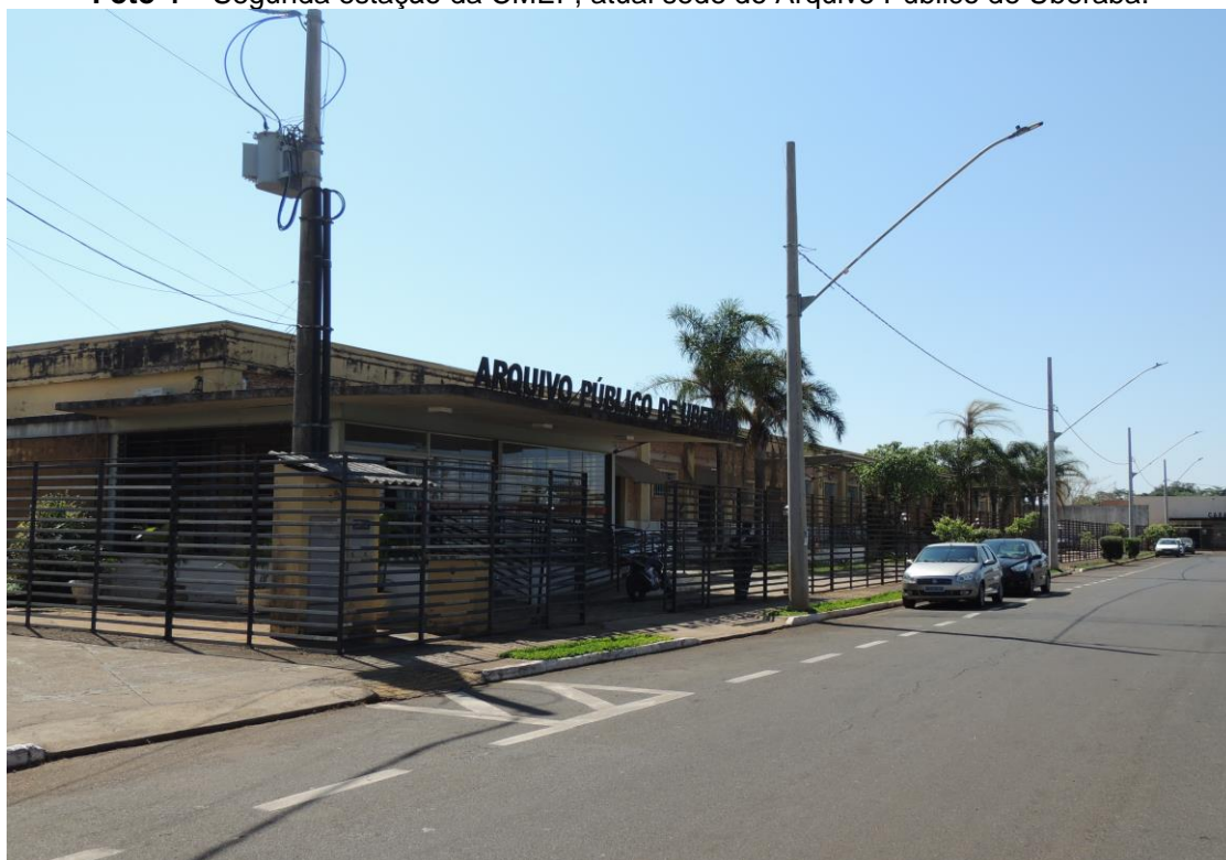
Foto 4 – Segunda estação da CMEF, atual sede do Arquivo Público de Uberaba.
