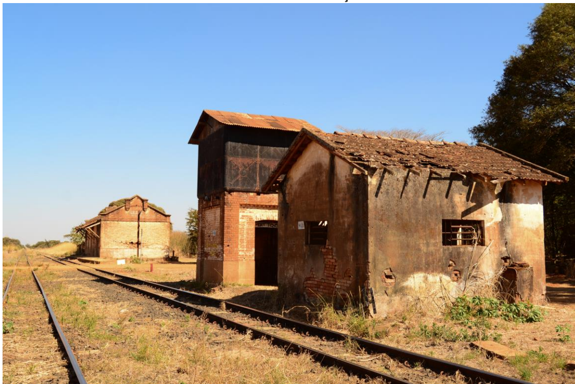
Foto 62 – Entorno da Estação Irara.
