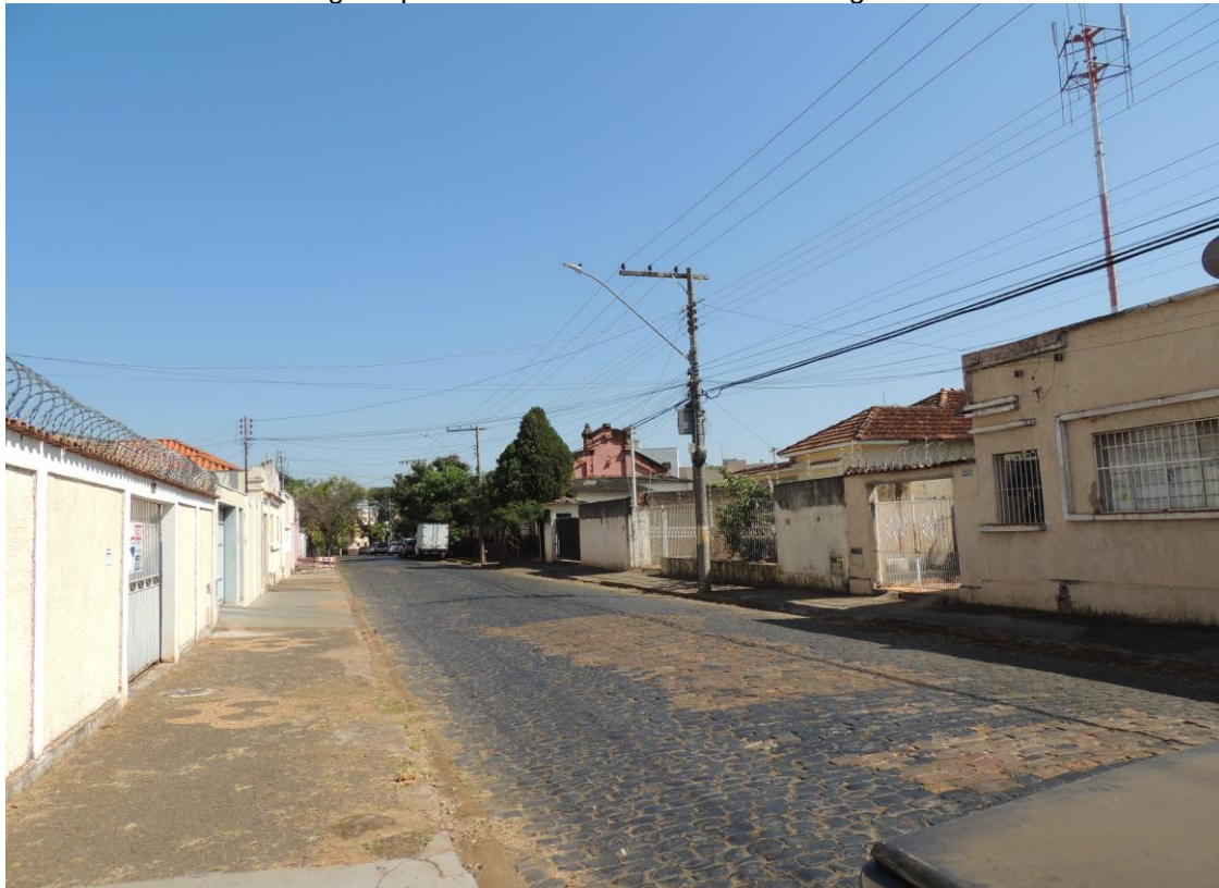
Foto 10 – Entorno do antigo depósito de mercadoria “Pavilhão Mogiana” da CMEF em Uberaba.
