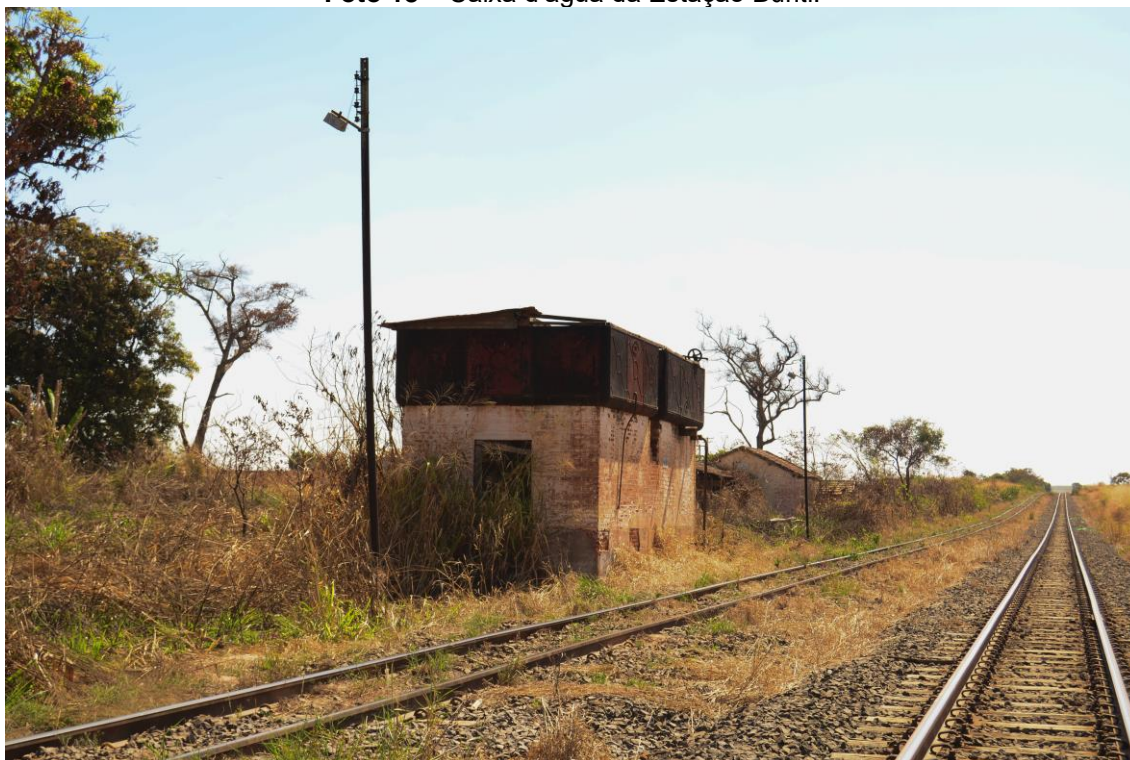
Foto 18 – Caixa d'água da Estação Buriti.
