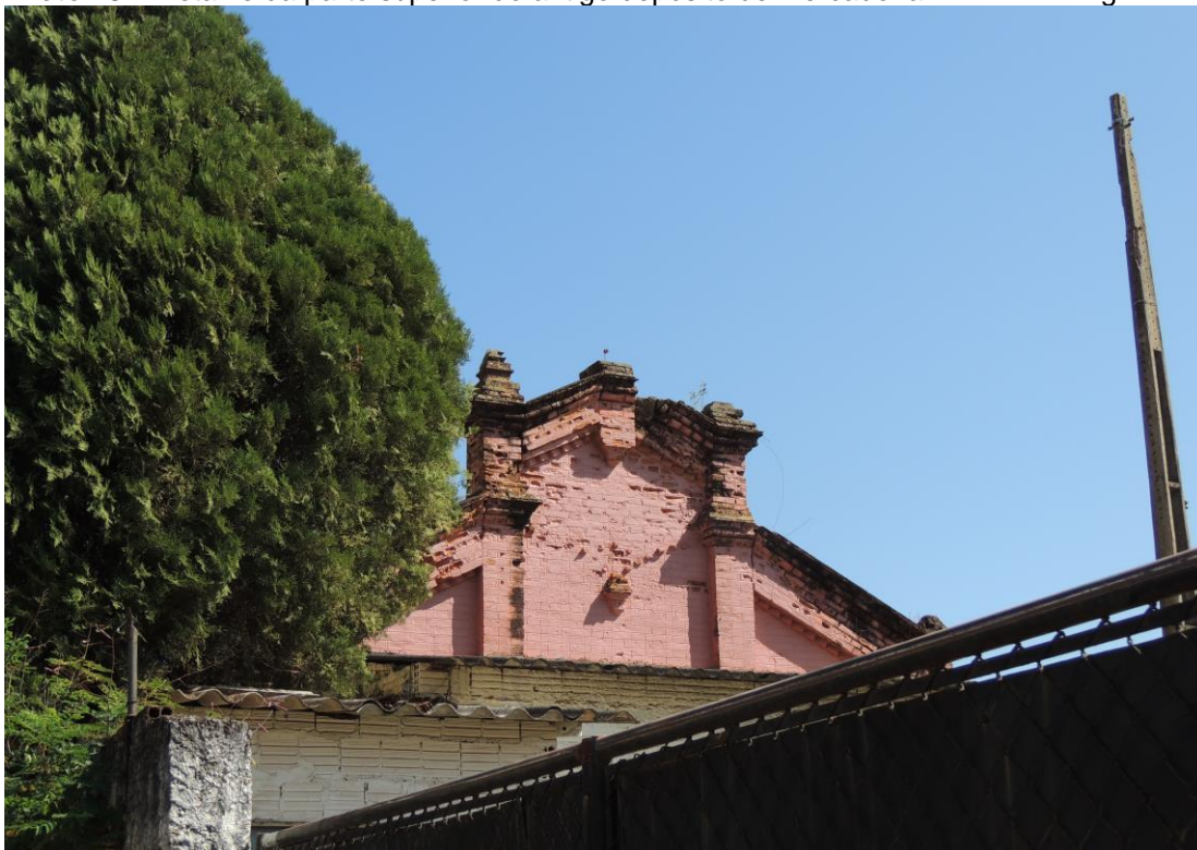
Foto 13 – Detalhe da parte superior do antigo depósito de mercadoria “Pavilhão Mogiana”.
