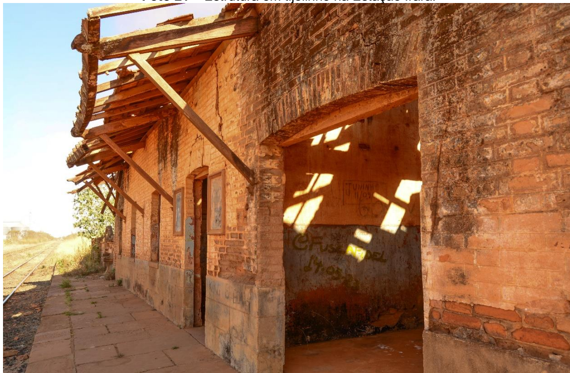
Foto 21 – Estrutura em tijolinho na Estação Irara.
