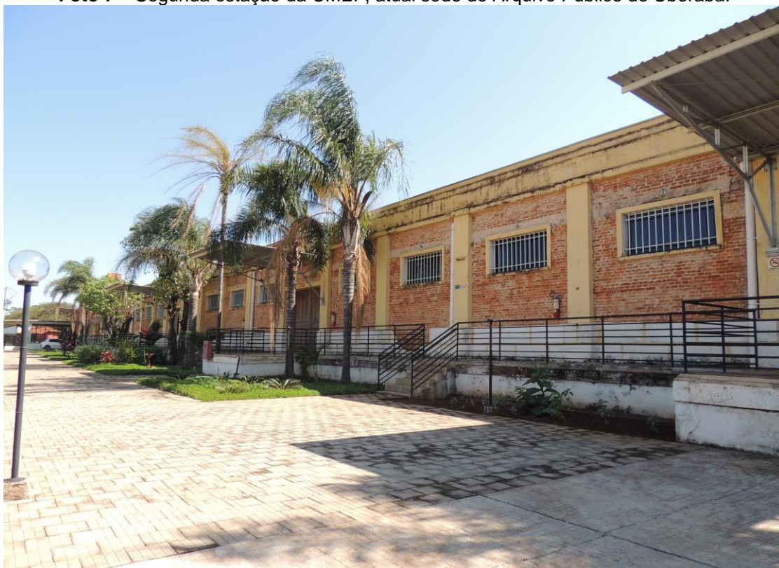
Foto 7 – Segunda estação da CMEF, atual sede do Arquivo Público de Uberaba.
