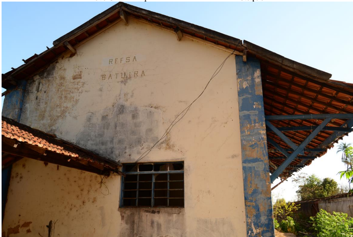
Foto 9 – Inscrição “RFFSA Bатуíra” na estação.
