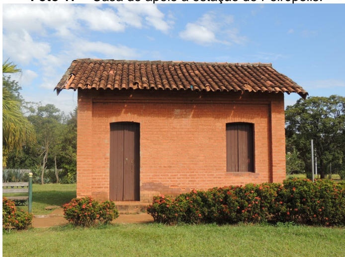
Foto 17 – Casa de apoio a estação de Peirópolis.
