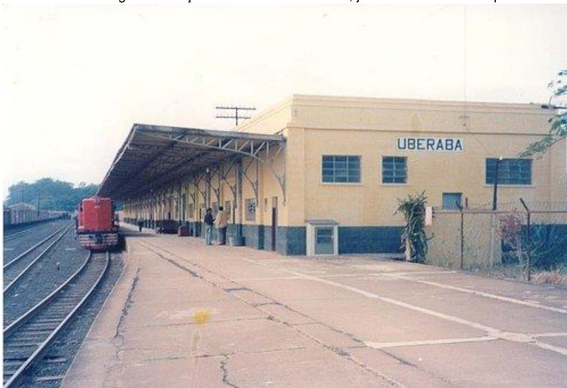
Foto 15 - Segunda estação da CMEF em Uberaba, já transformada em depósito.
