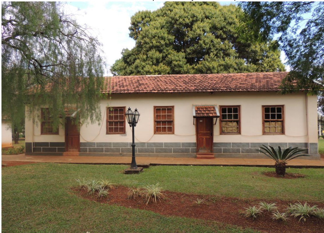
Foto 45 – Casa de apoio a estação de Peirópolis.
