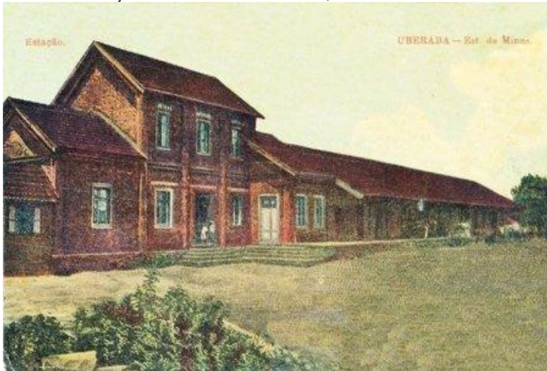
Foto 3 – Primeira estação da CMEF em Uberaba demolida, localizada na Rua Menelick de Carvalho.
