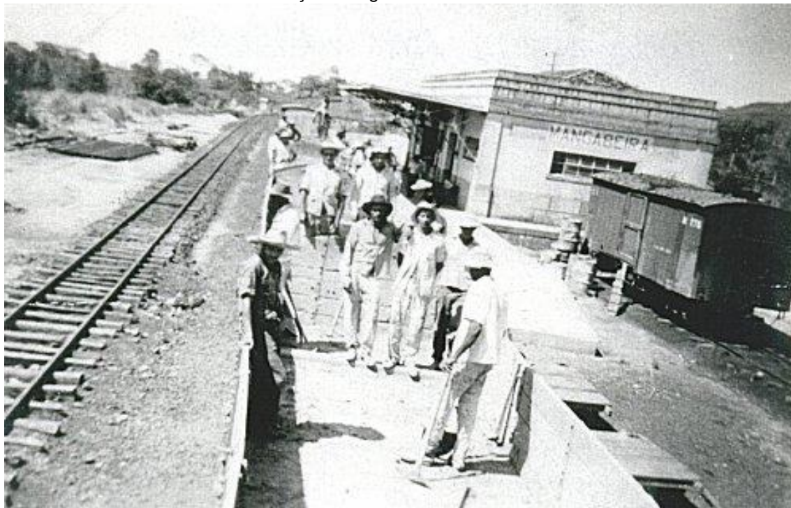
Foto 65 - Estação Mangabeira antes de ser demolida.
