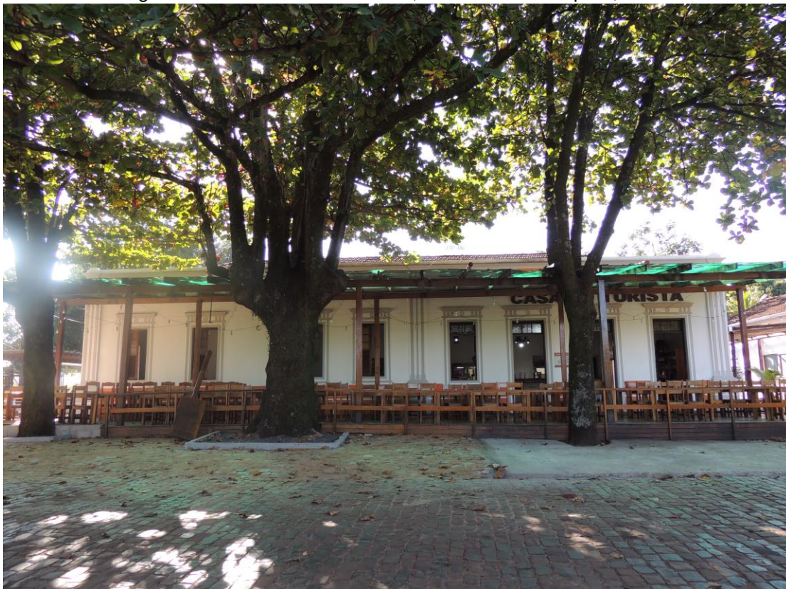
Foto 49 – Antiga residência de Frederico Peiró, fundador de Peirópolis, atual Casa do Turista.
