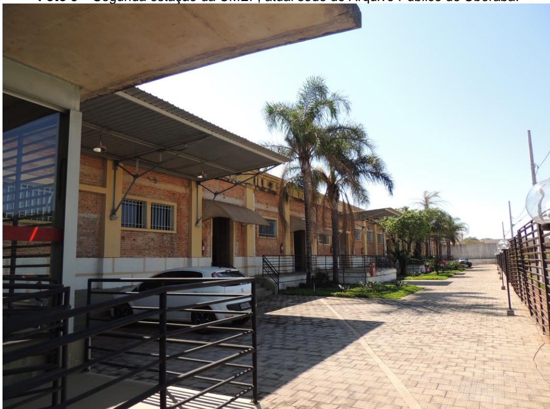
Foto 5 – Segunda estação da CMEF, atual sede do Arquivo Público de Uberaba.
