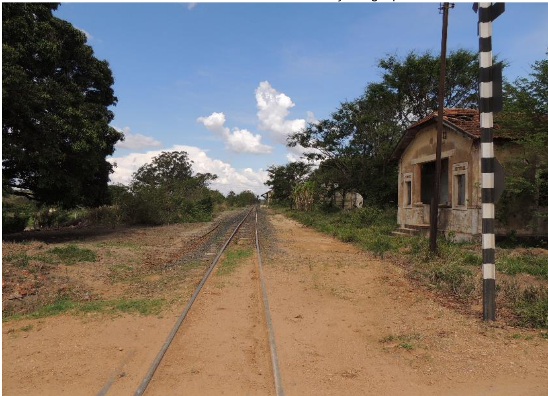
Foto 67 – Vista do entorno da estação Itiguapira.
