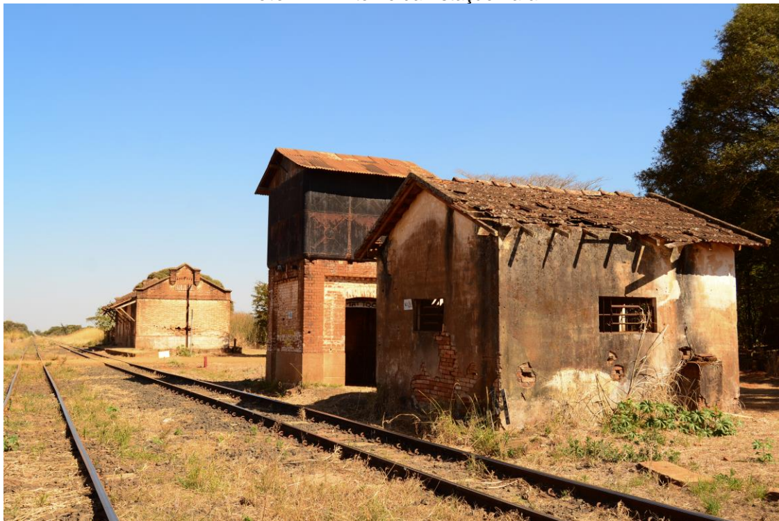
Foto 17 – Entorno da Estação Irara.
