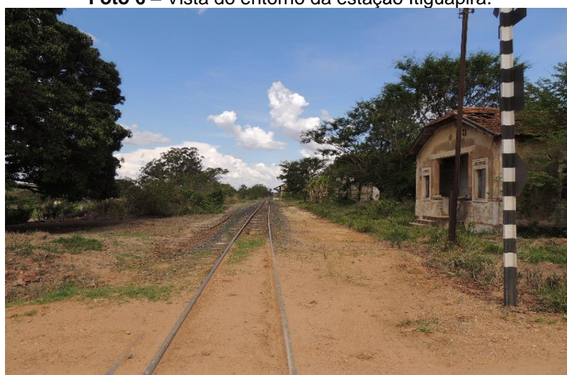
Foto 6 – Vista do entorno da estação Itiguapira.
