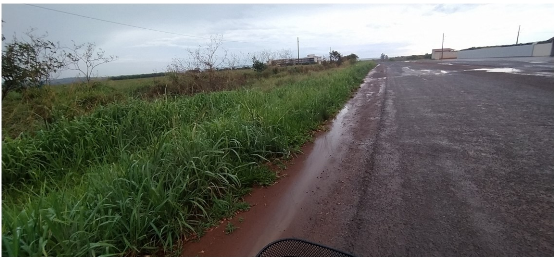
Figura 15 – Trecho da rodovia sentido a UFU
