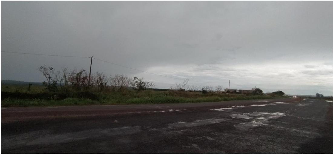
Figura 14 – Trecho da rodovia sentido a UFU
