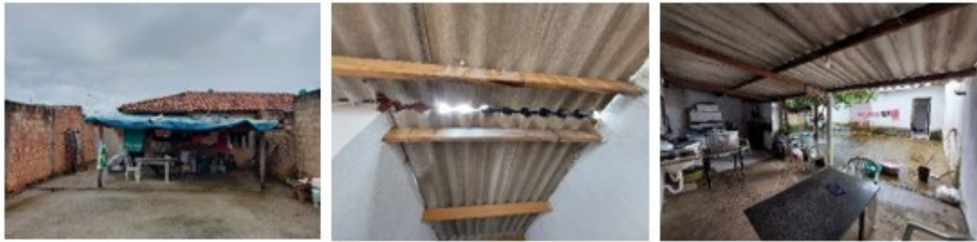
Figura 24 - Intervenções realizadas nas unidades habitacionais
