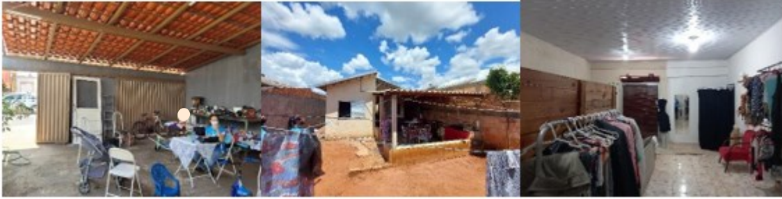
Figura 31 - Intervenções realizada pelos moradores.
