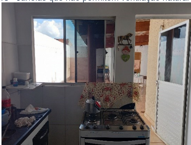
Figura 118 - Janelas que não permitem ventilação natural ao serem
