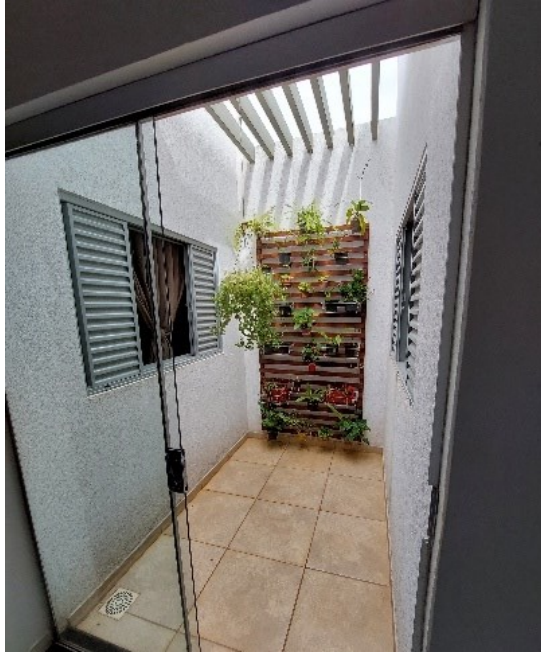
Figura 87 - Pátio interno sem área permeável.
