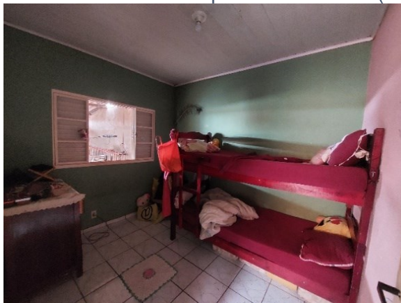
Figura 81 - Janela voltada para área coberta (R2A4)
