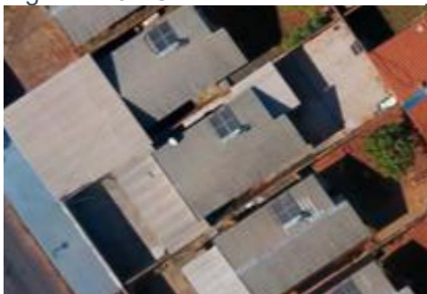
Figura 116 - Cobertura não obstruiu janela dos quartos R2A4
