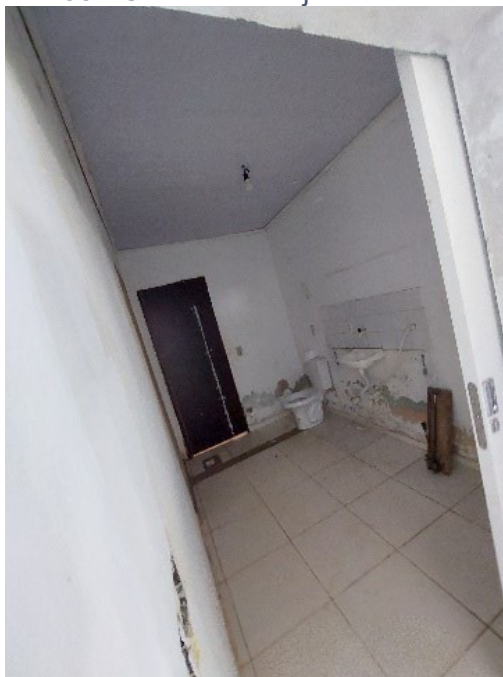
Figura 135 - Cômodo sem janela RSB
