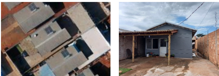
Figura 114 - Telhas de cimento e pintura externa em cores escuras no R2A4
