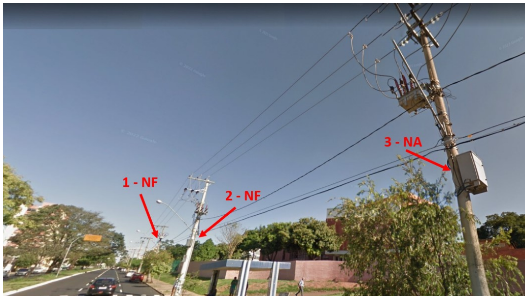
Figura 9: Sistema de self-healing na Universidade Federal de Uberlândia
