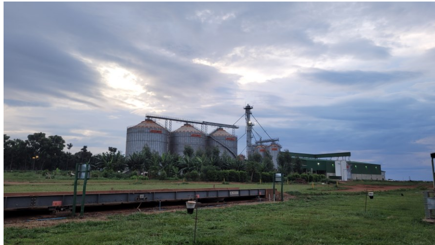
Figura 26 - Local da estação base da Fomus, prédio UBT.
