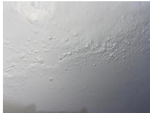
Imagem 3: Presença de criptoflorescências na parede analisada.
