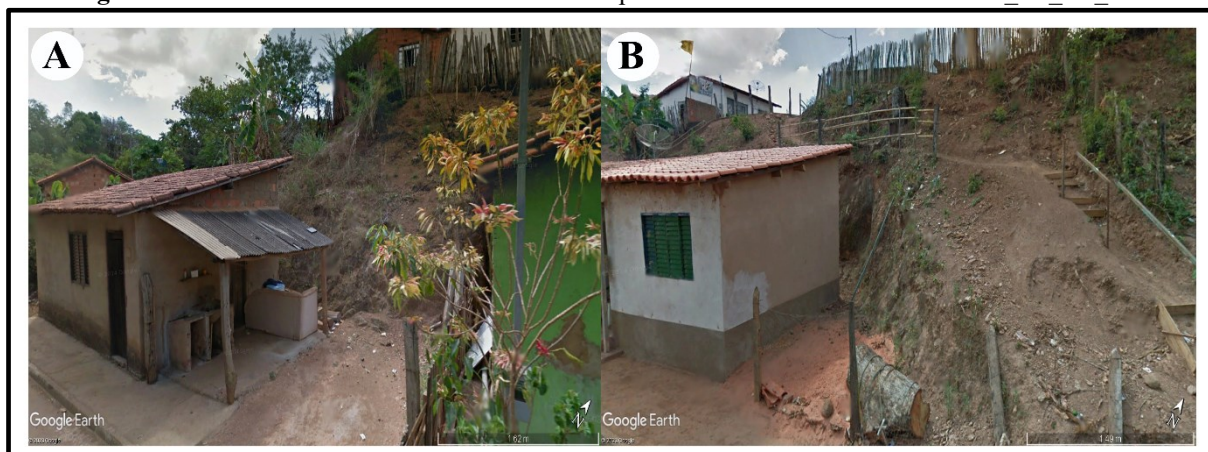
Figura 42: A. e B. Vista de taludes de corte muito próximos a residências no setor MG_ES_SR_06.
