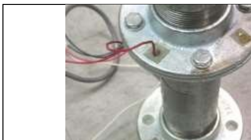
(c) – Estrutura tubular flangeada para monitoramento de tensão.
