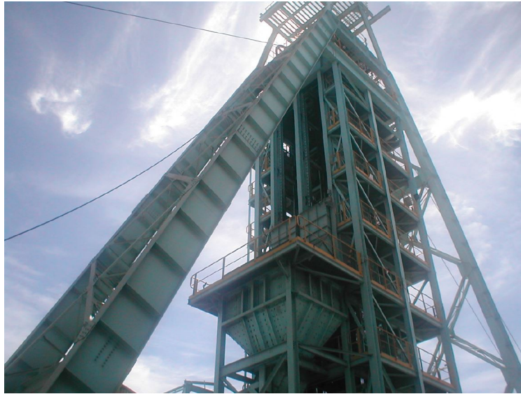
Figura 94 – Fotografia de um sistema de guindaste de uma mina subterrânea de ouro. Fonte: (Ferreira et al., 2018).
