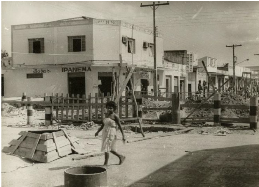
Figura 2: Imperatriz- Início das obras do Calçadão
