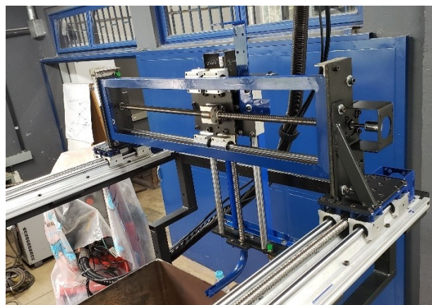
Figura 0.7 – Montagem dos atuadores sobre o pórtico
