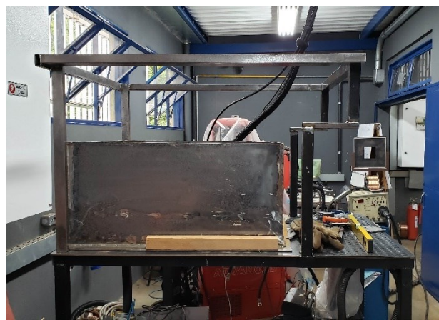
Figura 0.5 – Montagem do pórtico superior
