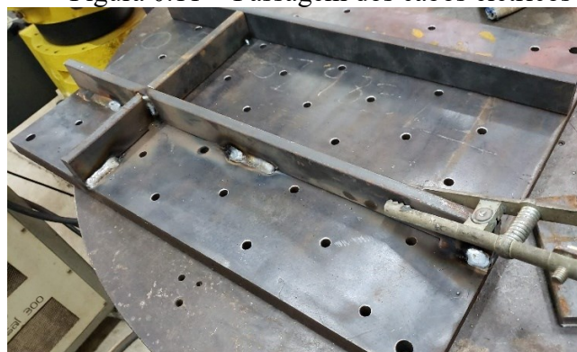
Figura 0.13 – Soldagem das travessas da plataforma de construção
