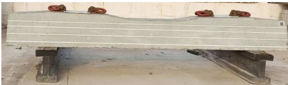
Figura 89 : Marcação das armaduras
