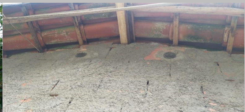
ABERTURAS ALTAS PARA VENTILAÇÃO DO TELHADO
