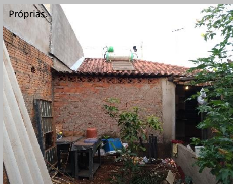
TIJOLO TIPO COBOGÓ VENTILANDO ESPAÇO ENTRE TELHAS E FORRO
