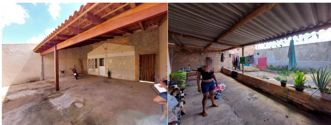
Figura 51 - Coberturas para frente e fundo no CA2/2A4.
