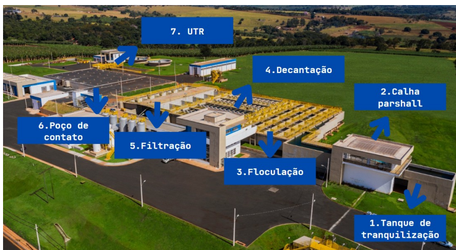
Figura 1: ETA Capim Branco e as etapas do tratamento de água
