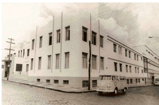
Figura 16 - Foto da fachada externa da Faculdade de Filosofia, Ciências e Letras
