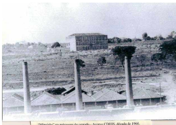
Figura 20 - Foto do prédio da Faculdade Federal de Engenharia no Santa Mônica
