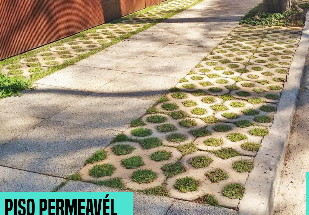
Figura 101: Piso Permeável
