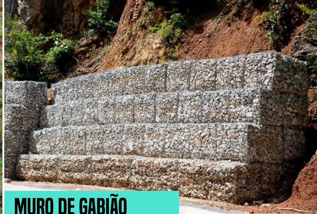
Figura 100: Muro de Gabião
