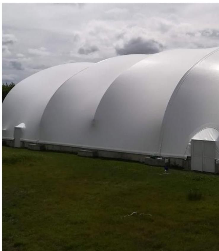
Figura 54: Proteção com membrana de PVC. Fonte: Interempresas
