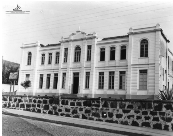
Figura 2 – Prédio em reforma para funcionamento da FMTM – Década de 1950 (sem ano definido)
