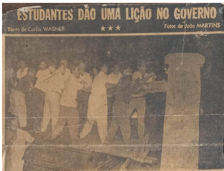
Figura 8 – Alunos trabalhando na reforma do prédio da FMTM (31 de março de 1959)
