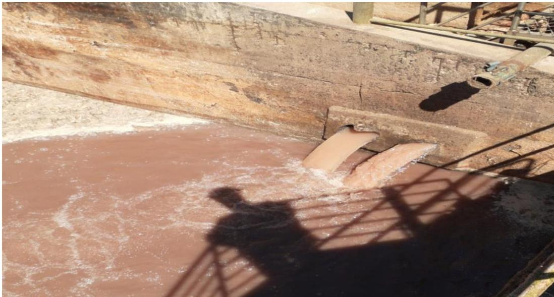
*Figura 7.* Recebimento do efluente bruto. Fonte: foto retirada pelo autor.
