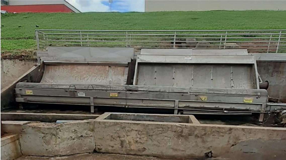
Figura 8. Peneira estática, tratamento primário. Fonte: Foto retirada pelo autor.
