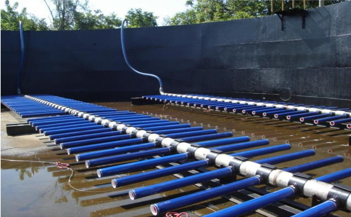
Figura 6. Modelo de reator ou lagoa aerada por ar difuso. Fonte: <https://wasserlink.wordpress.com/tag/lagoa-aerada/> . 27/05/2023.
