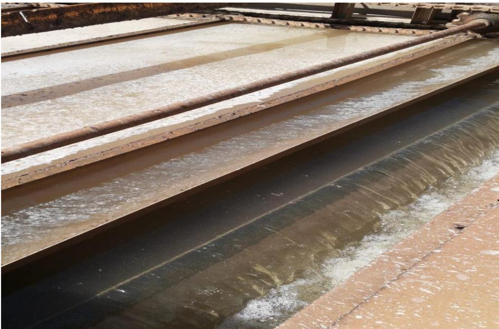
Figura 15. Efluente tratado transbordando do decantador. Fonte: Autor
