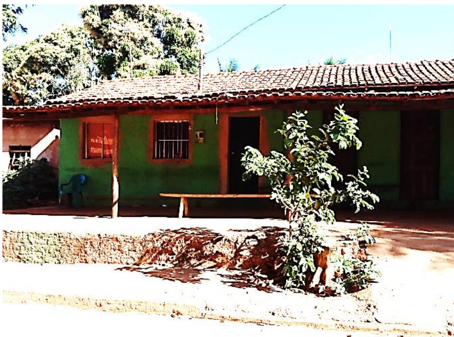
Figura 17 - Vista parcial da casa da Carlúcia
