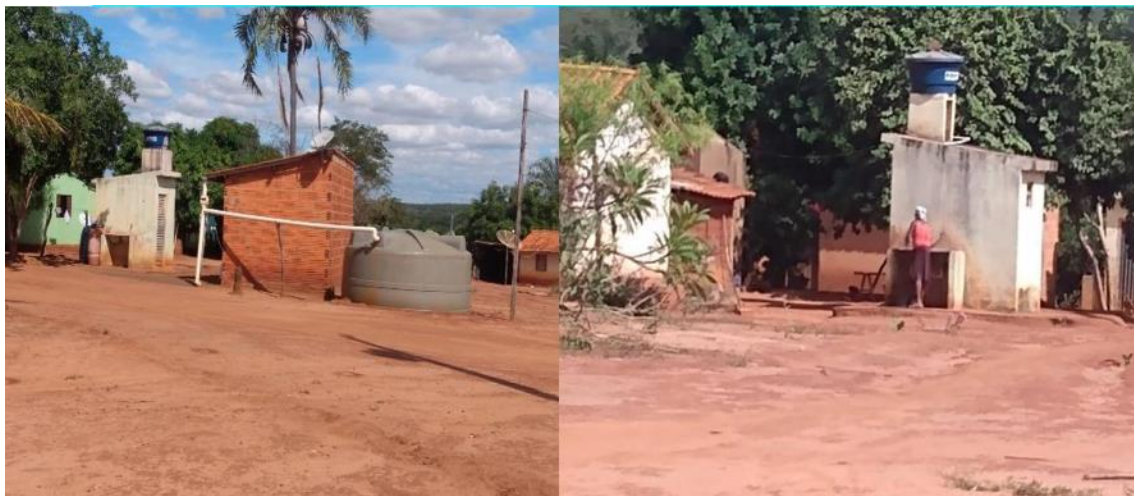
Figura 64 - Políticas públicas – Instalação de caixas d’água e banheiros sanitários e tanque
