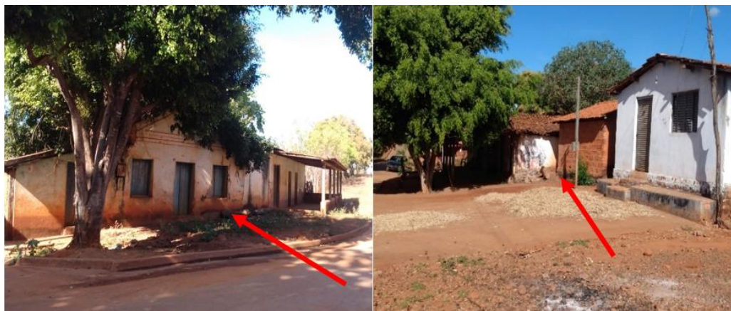
Figura 43 - Construções antigas de adobe na comunidade Araruba/Brejo dos Crioulos
