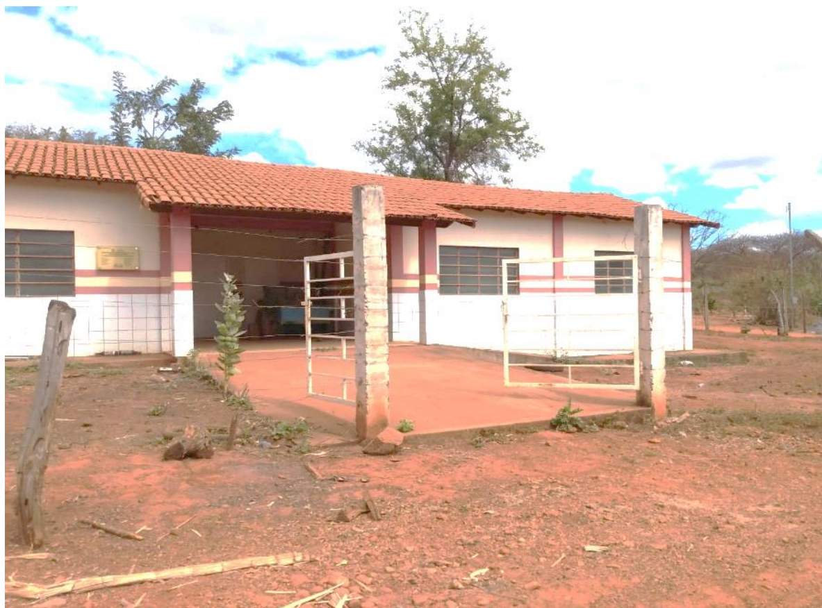
Figura 47 - Prédio onde funcionava a Escola Municipal de Ribeirão Arapuim
