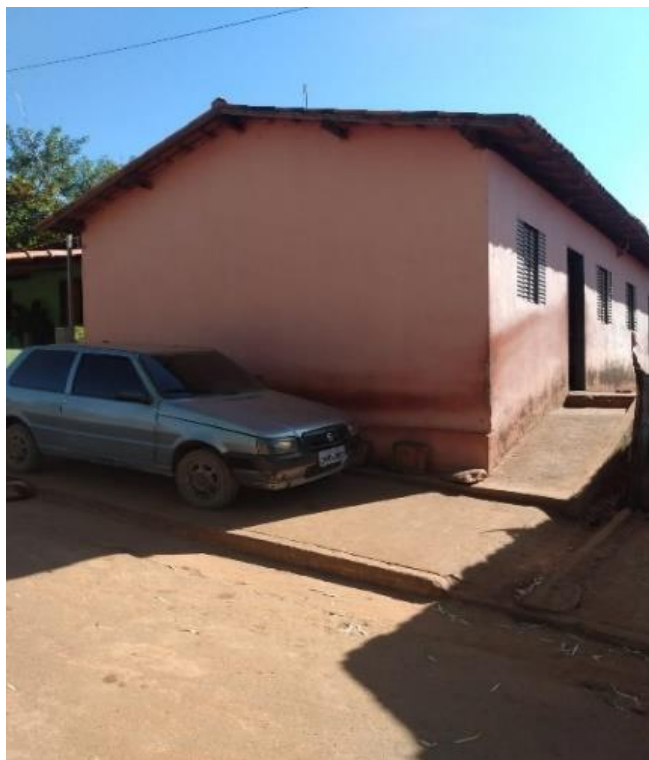
Figura 14 - Vista parcial da casa de Justina
