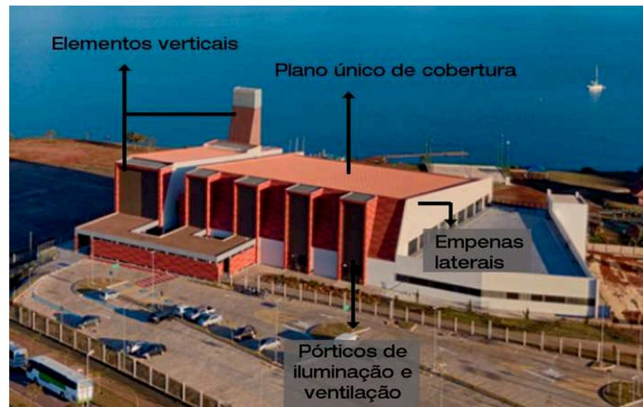
Figura 49: Perspectiva externa com detalhes da volumetria.
