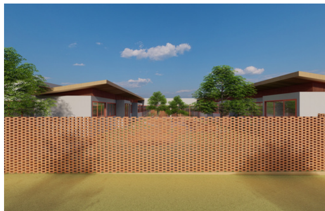
Utilização de tijolo aparente no fechamento do bloco de terapias. Fonte: Autora, 2023.
