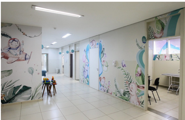
Corredor com iluminação artificial e sem ventilação e consultórios com pouca iluminação e ventilação natural. Fonte: Missão Sal da Terra , 2022.
