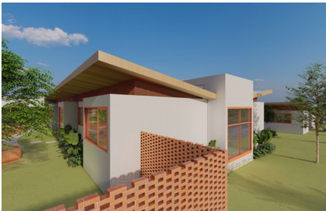
Cobertura de telha sanduíche descolada do volume e tela metálica para ventilação e proteção. Fonte: Autora, 2023.
