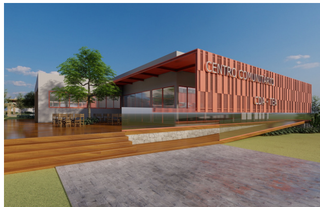
Utilização de materiais e cores naturais na fachada do Centro Comunitário. Fonte: Autora, 2023.
